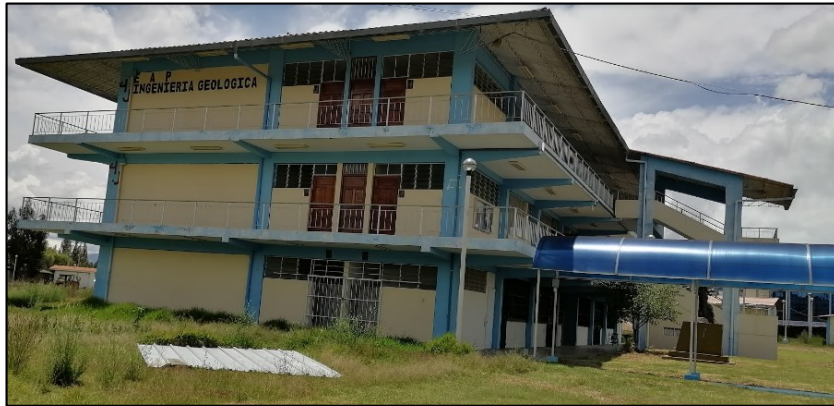
Fotografía 5.19: EAP en la Ciudad universitaria ubicada en la Manzana 43
