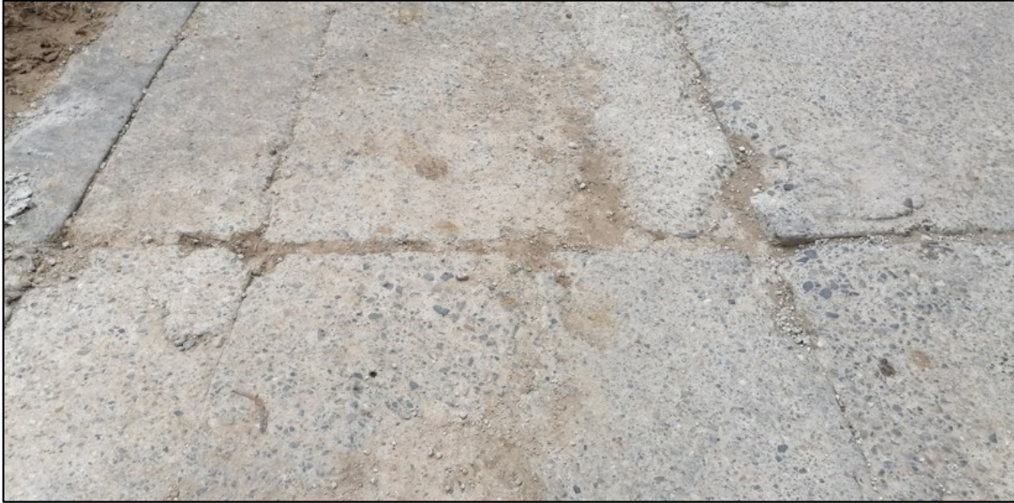
Fotografía 5.32: Calzada en el Jr: Libertadores, entre Av: Mártires de Uchuracay y Jr: Juan Beato Macías
