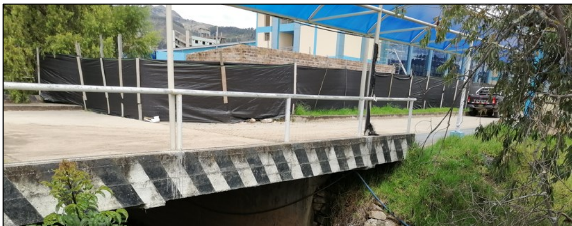
Fotografía 5.61: Estructura hidráulica (puente) en el canal Calispuquio, en la Universidad Nacional de Cajamarca
