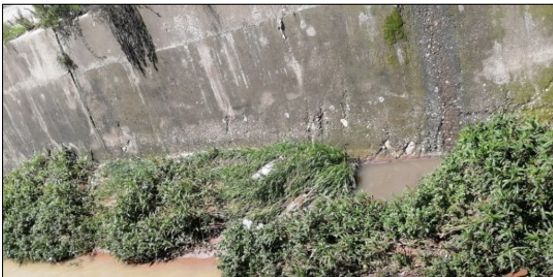
Fotografía 5.60: Estructura principal del canal Calispuquio en la Av: Vía de Evitamiento Sur
