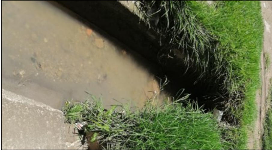
Fotografía 5.67: Estructura principal del canal El Ingenio, entre Jr: Misión Bautista y Jr: Yahuarhuaca
