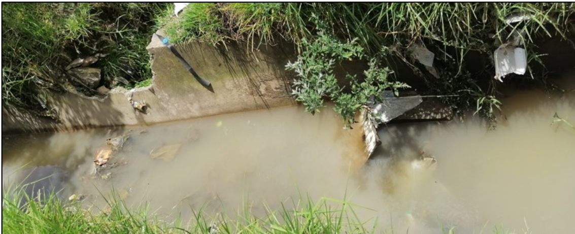
Fotografía 5.68: Estructura principal del canal El Ingenio, entre Jr: Santa Beatriz y Av: Industrial
