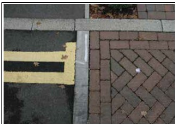
Figura 22: Fuerte contención de bordes con bloques en espiga en el pavimento permeable
