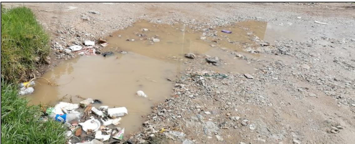
Fotografía 5.41: Calzada en la Av: Industrial, entre Av: Mártires de Uchuracay y Psje: Los Cartuchos
