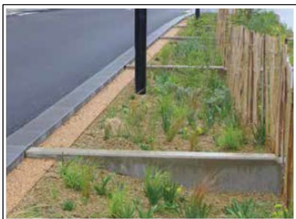
Figura 12: Colocación de diques de contención en intervalos moderados en el sistema de biorretención
