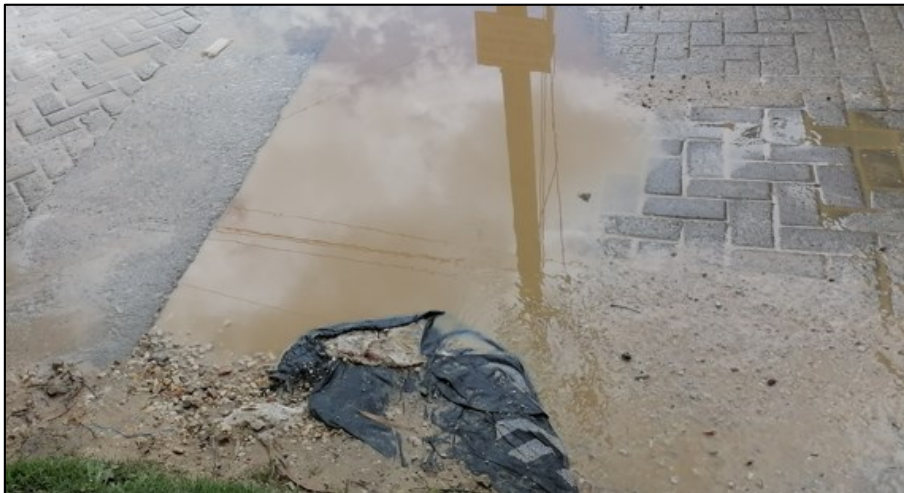
Fotografía 5.45: Calzada en la Av: Mártires de Uchuracay, entre Jr: San Camilo y Jr: Larry Jhonson
