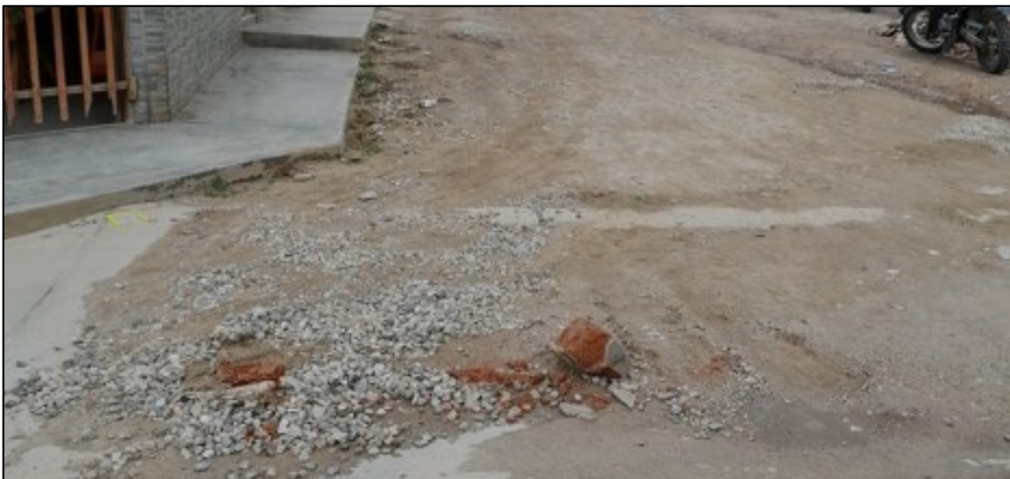
Fotografía 5.38: Calzada en el Jr: Yahuarhuaca, entre Av: San Martín de Porres y Av: Mártires de Uchuracay
