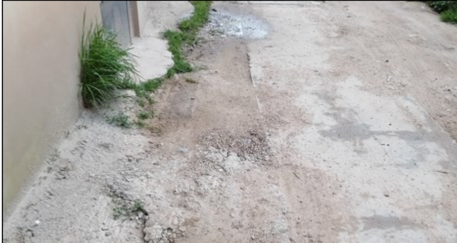
Fotografía 5.29: Calzada en el Psje: Los Cartuchos, entre Psje: Los Eucaliptos y Jr: Colonial
