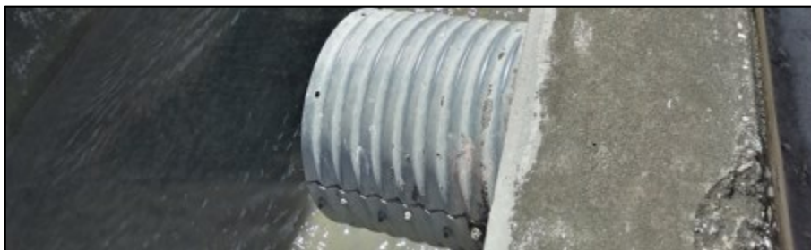
Fotografía 5.64: Estructura hidráulica (alcantarilla) en el canal Calispuquio, en la Prolg: E Progreso
