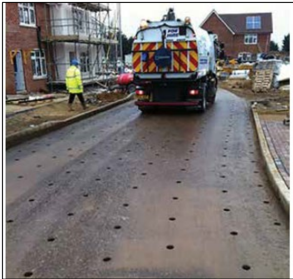
Figura 20: Capa de asfalto utilizada para proteger las sub-base del pavimento permeable, del tráfico de la construcción
