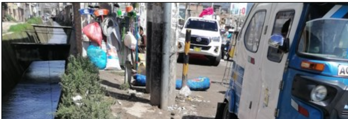
Fotografía 5.58: Faja marginal en un tramo del canal Calispuquio en Prolg: El Progreso
