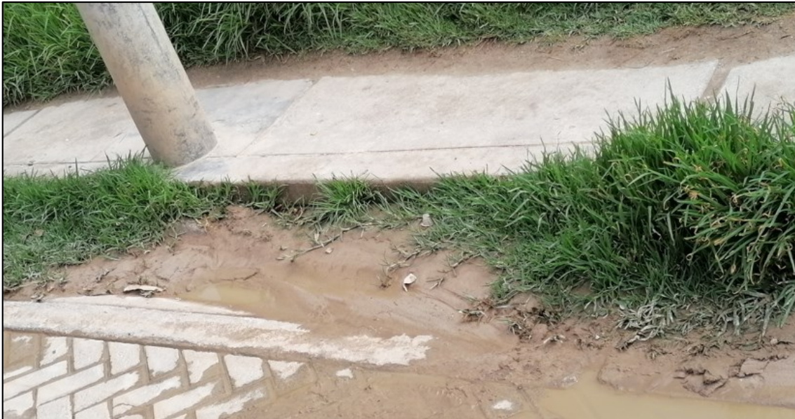
Fotografía 5.43: Vereda y cuneta en la Av: Mártires de Uchuracay, entre Jr: San Camilo y Jr: Larry Jhonson
