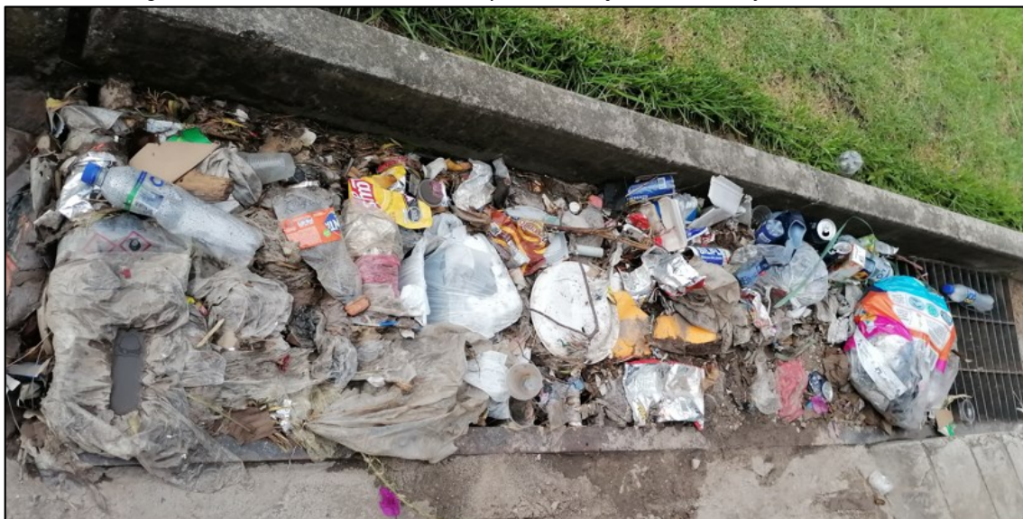
Fotografía 5.51: Canal de la Av: Atahualpa, entre Psje: Coricancha y Av: Universitaria
