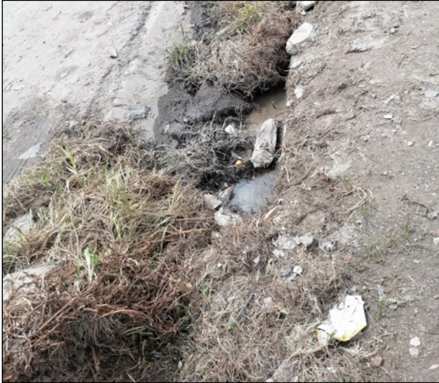
Fotografía 5.22: Cuneta de la Av: Vía de Evitamiento Sur, entre Av: Atahualpa y Jr: El Milagro
