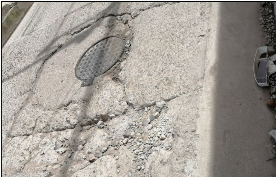
Fotografía 5.54: Calzada del Psje: Coricancha
