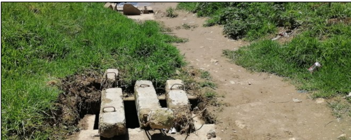
Fotografía 5.69: Estructura (tapas de concreto) en el canal El Ingenio, entre Jr: Los Conquistadores y Av: Héroes del Cenepa
