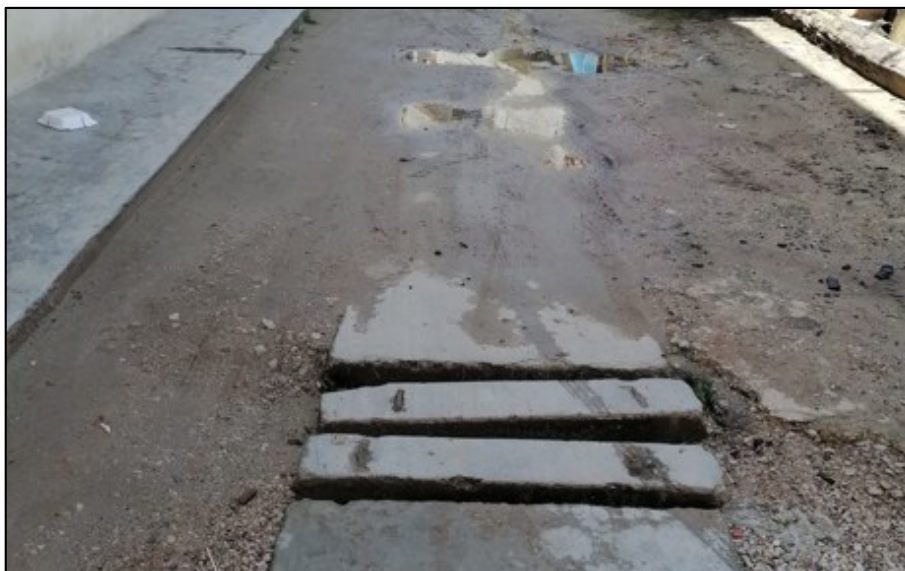
Fotografía 5.66: Fajas marginales en el canal El Ingenio, entre Psje: Las Guirnaldas y Jr: Los Tulipanes
