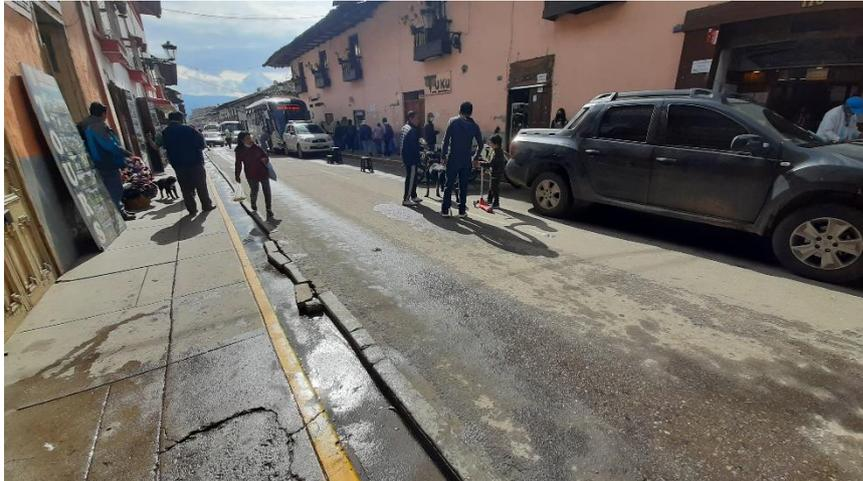
*Nota: vereda y cuneta en deterioro, ninguna señalización horizontal y vertical y autos estacionados en línea amarilla.*
