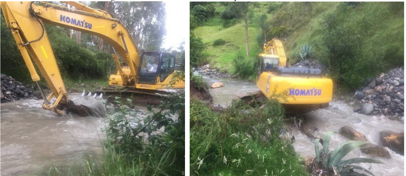
Figura 29: Excavación de la trampa de sedimentos
