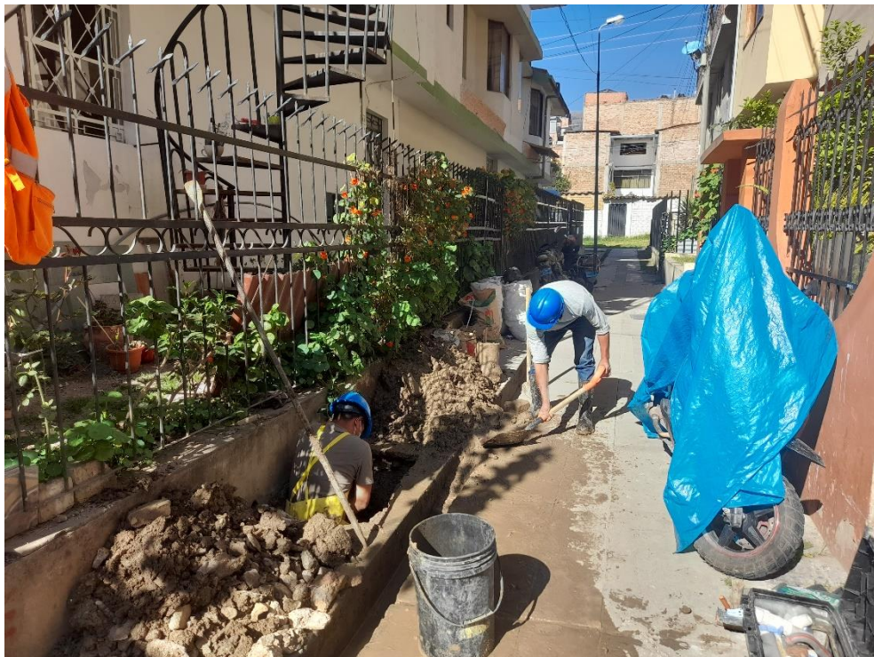
Figura 57: Excavación para reparación de fuga en abrazadera.
