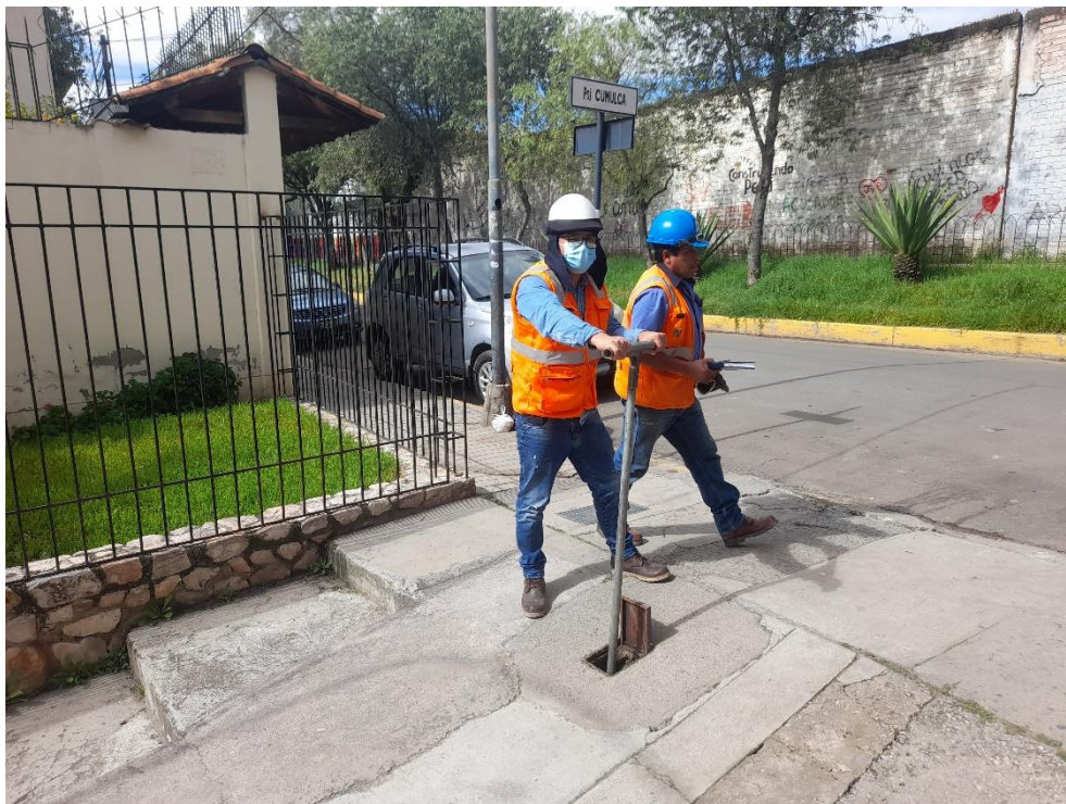
Figura 47: Verificación de la hermeticidad de válvulas de control.
