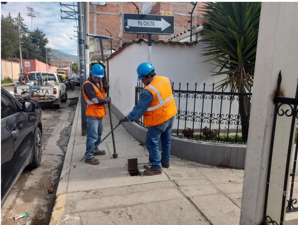
Figura 36: Personal técnico realizando limpieza de tubo señal de válvulas de control.
