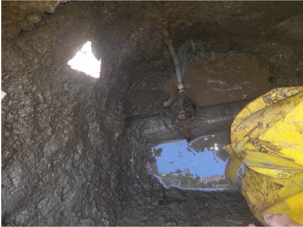
Figura 58: Fuga en abrazadera.
