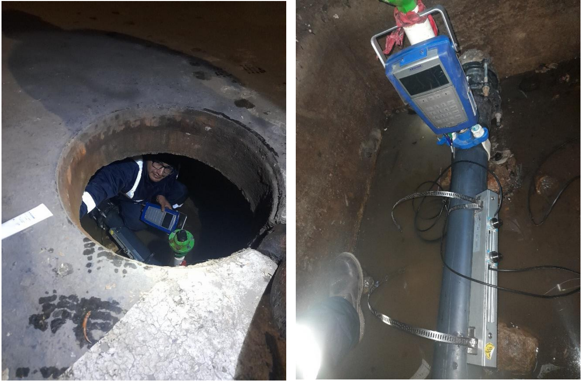
Figura 38: Instalación del Caudalímetro portátil en la tubería de ingreso de agua potable.
