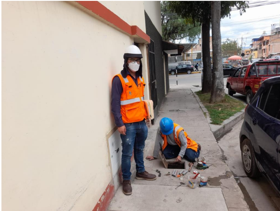
Figura 65: Retiro de micromedidores con apoyo de personal técnico de la EPS.
