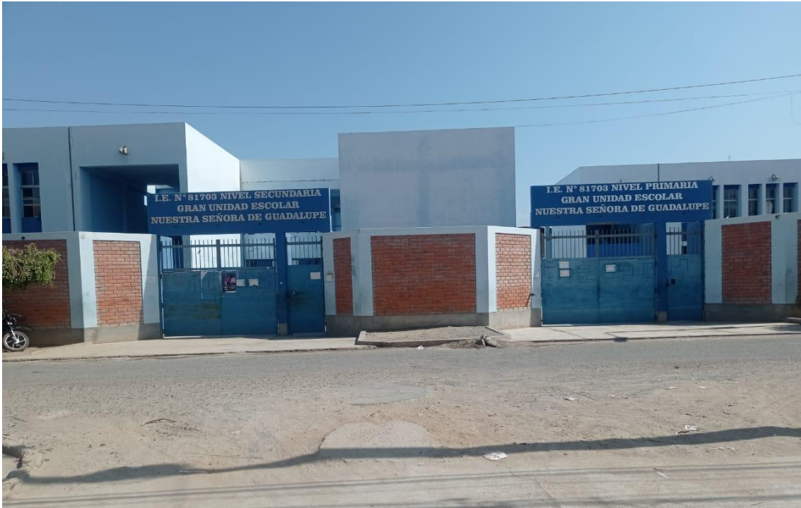
Fotografía 1: Fachada principal de la Institución Educativa I.E. N° 81703 “Gran Unidad Escolar Nuestra Señora de Guadalupe”.
