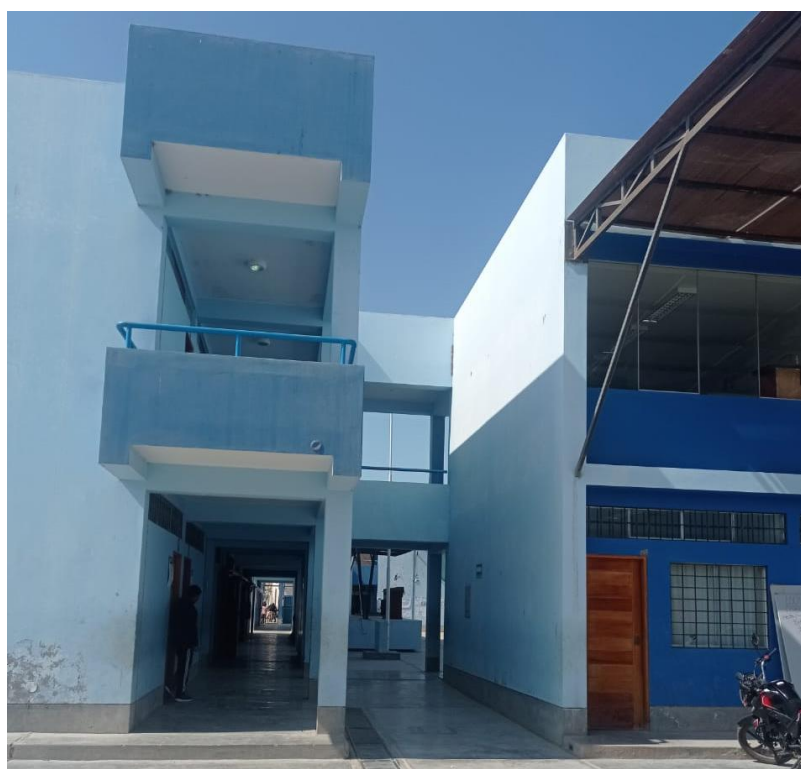
Fotografía 6: Vista lateral panorámica del Pabellón “D” de la Institución Educativa I.E. N° 81703 “Gran Unidad Escolar Nuestra Señora de Guadalupe”.
