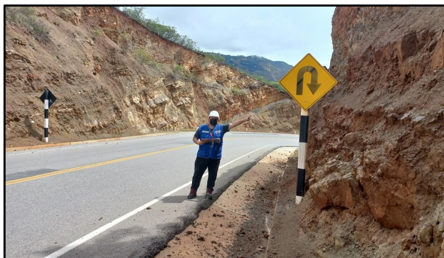
Fotografía 3: Inspección de dispositivos de control de Tránsito
