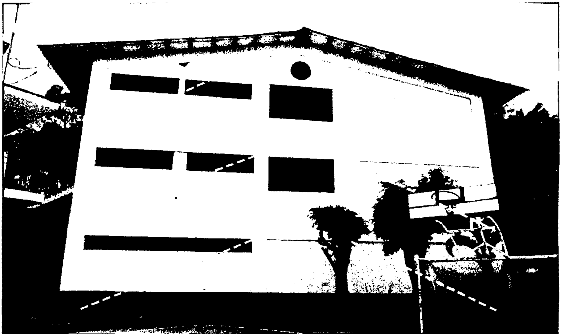
Figura 91. Vista posterior del Edificio Principal de la Universidad Nacional de Cajamarca – Sede Jaén, con la posible ubicación de los disipadores en la dirección Y-Y
