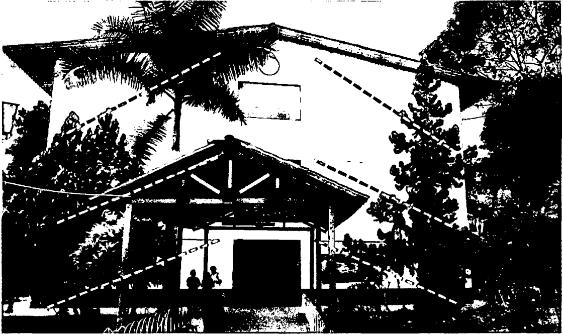
Figura 90. Vista frontal del Edificio Principal de la Universidad Nacional Cajamarca – Sede Jaén, con la posible ubicación de los disipadores en la dirección Y-Y
