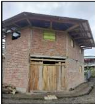
Foto 17. Meriania hexamera Sprague (vigas y puerta provisional) y Alzatea verticillata Ruíz & Pav.(pilares)
