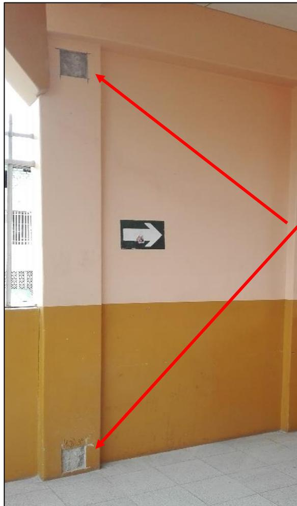
Cortes superior e inferior en columnas
