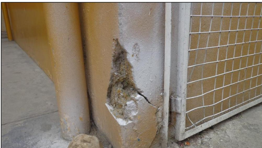
Fig. 5.14 Se observó humedad en la base lo muros y columnas de la parte exterior del bloque en estudio.
