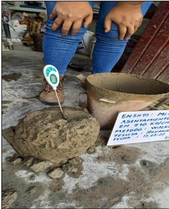
Foto N°17: se realiza la toma de temperatura del concreto por método y para cada resistencia.
