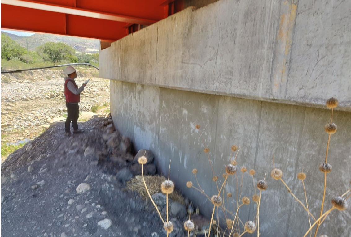
Fotografía N°03: Inspección in situ del estado actual del puente Malcas (Estribos).
