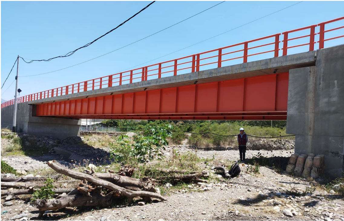
Fotografía N°01: Vista longitudinal del puente Malcas
