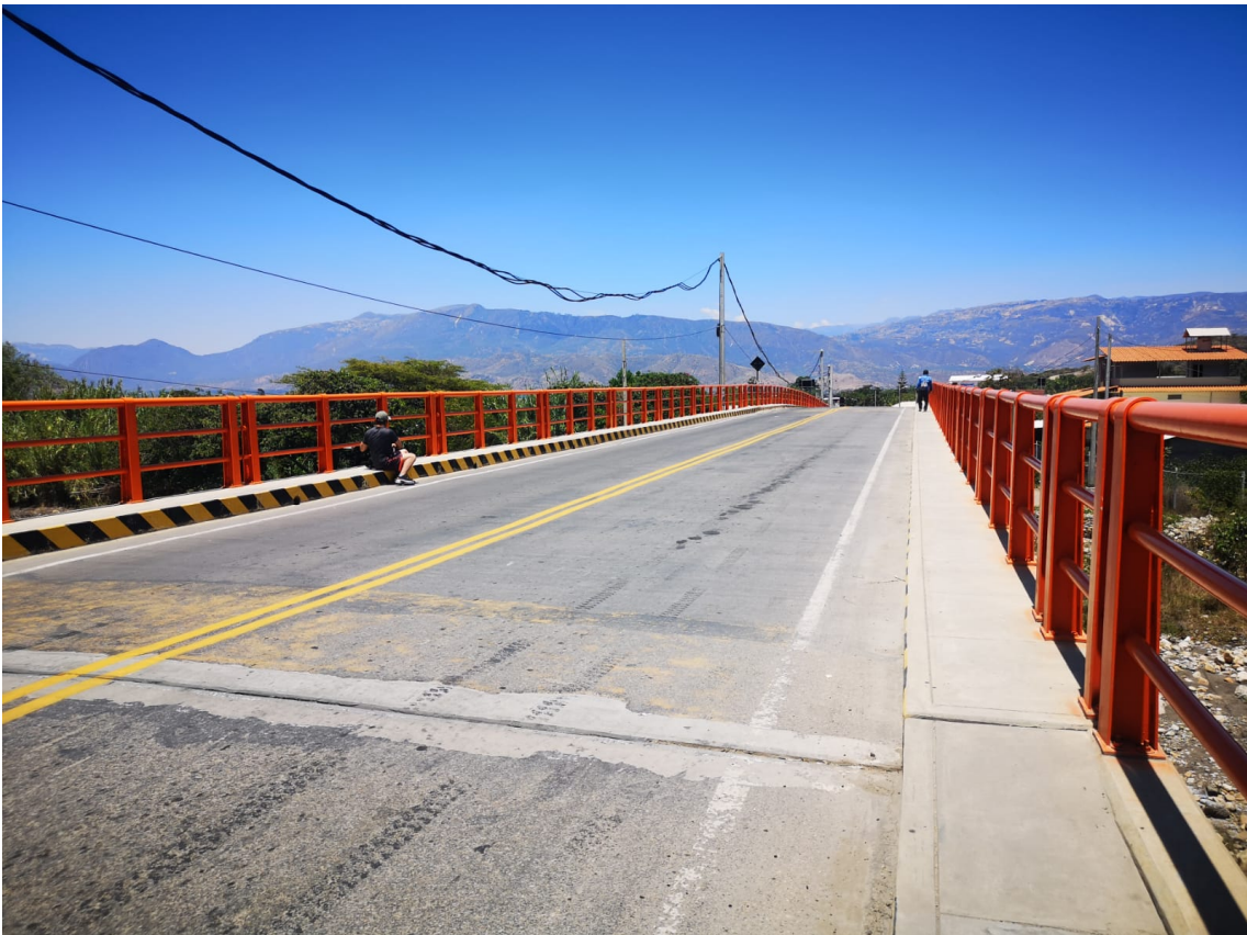
Fotografía N°06: Inspección in situ del estado actual del puente Malcas (Juntas, Asfalto, Veredas y barandas).
