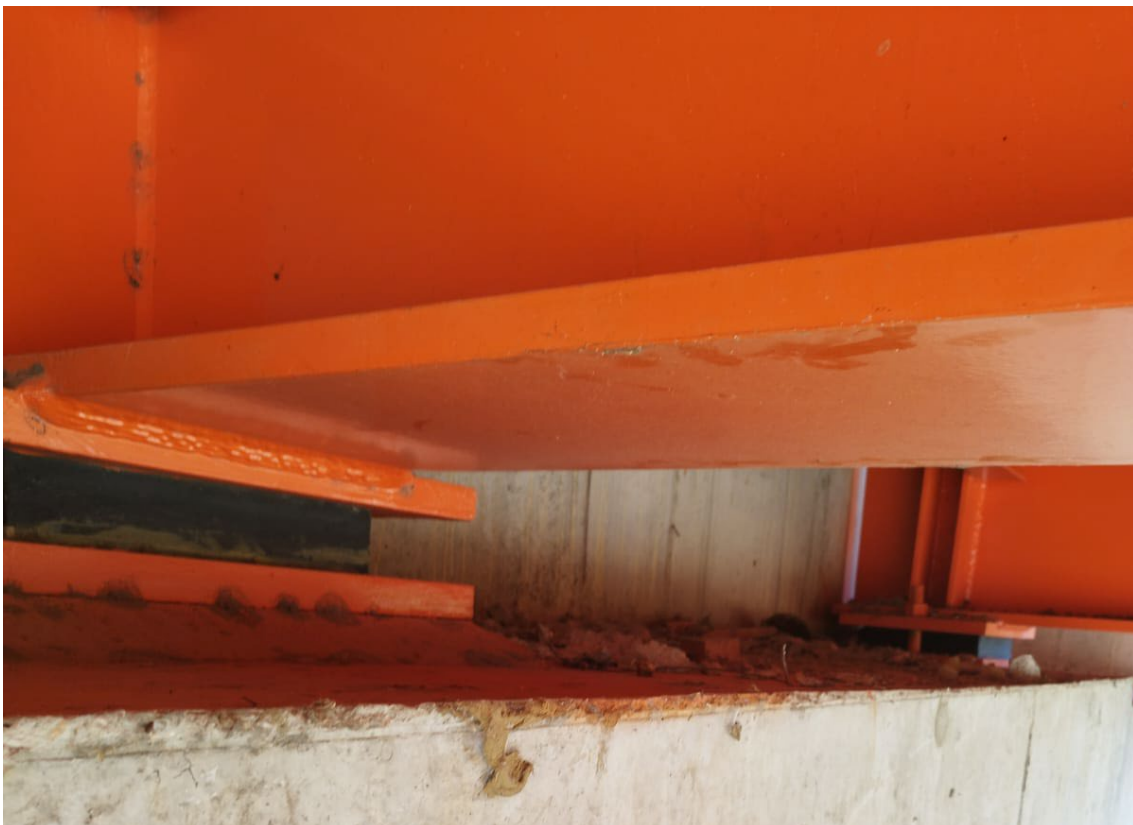
Fotografía N°04: Inspección in situ del estado actual del puente Malcas (Apoyos de Neopreno).
