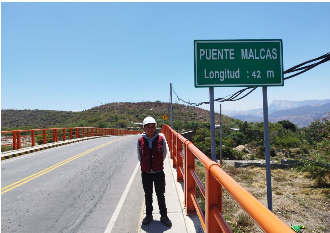
Fotografía N°02. Vista Frontal del puente Malcas
