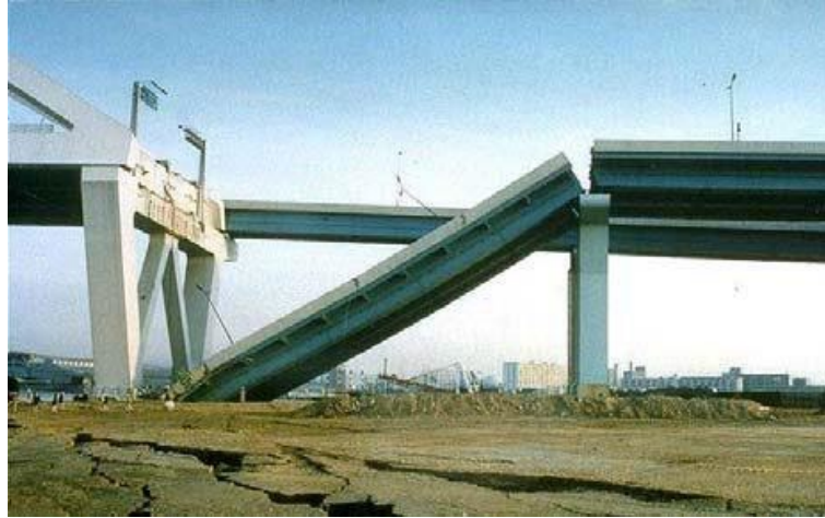
Figura N°2 Falla ocasionada por desplazamientos longitudinales excesivos Fuente: Landa, 2006.
