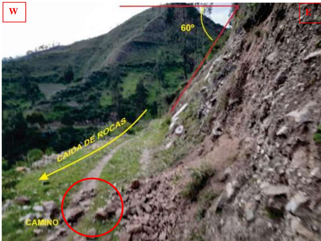
Figura 28. Caída de rocas RM- 08. Se observan fragmentos de rocas caídos al camino que conduce a la localidad de La Ramada. Coordenadas UTM N: 9218325 E: 769494
