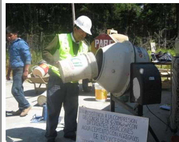
Figura 187. Preparación de mezcla para concreto de acuerdo a dosificación.
