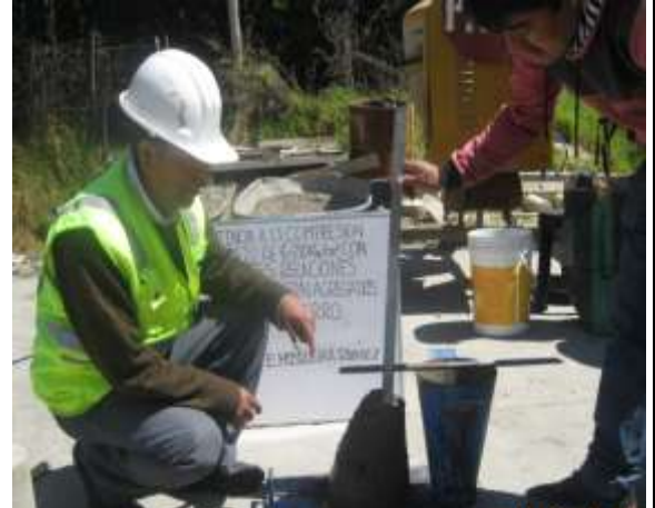
Figura 188. Chequeo de slum en la preparación de concreto.
