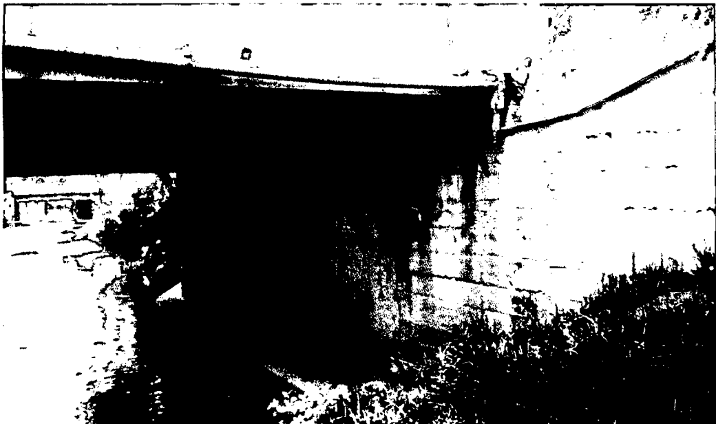
Figura 18. Socavación aguas abajo en el estribo derecho del puente y acumulación de sedimentos.
