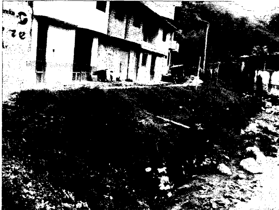
Figura N° 4.5. Depósito de tierra y vegetación en el ala derecha aguas arriba del puente.
