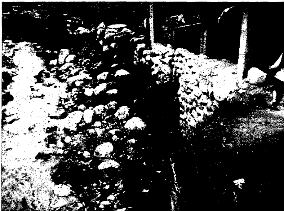
Figura N° 4.6. Acumulación de piedras y vegetación en el ala derecha aguas abajo del puente.
