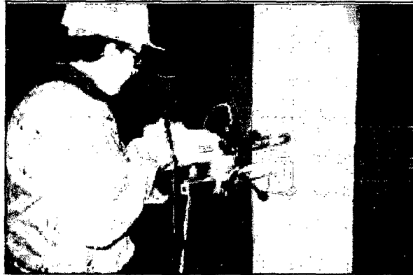
Figura N° 2.11. Extracción de testigos de concreto.
