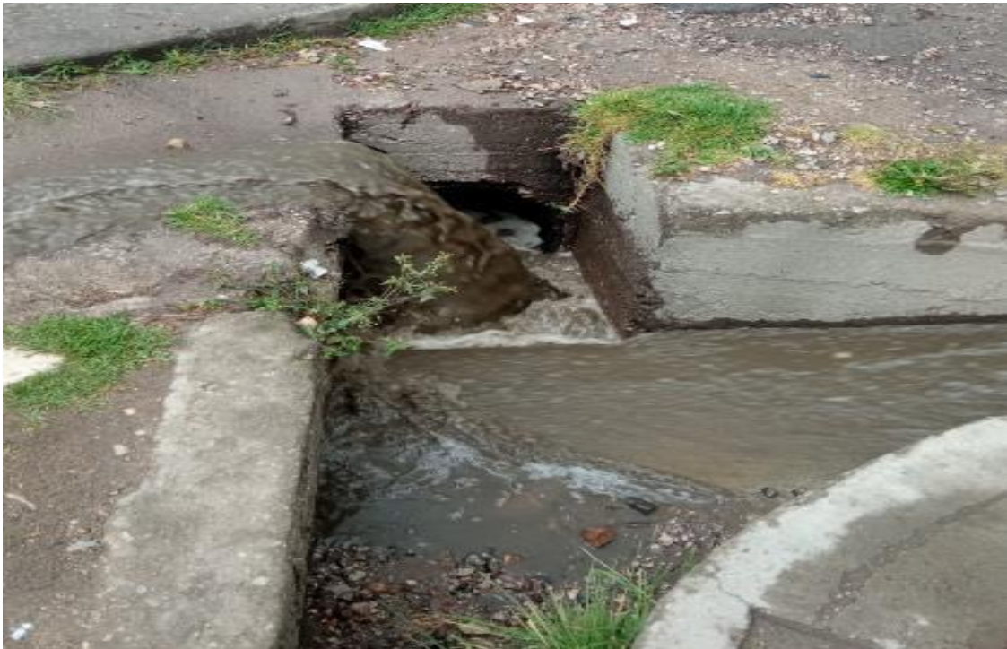
FOTOGRAFÍA N° 10 Construcciones sobre las cunetas para paso vehicular en la cuadra 4 del Jr. Los Sauces – urbanización El Ingenio – Cajamarca.
