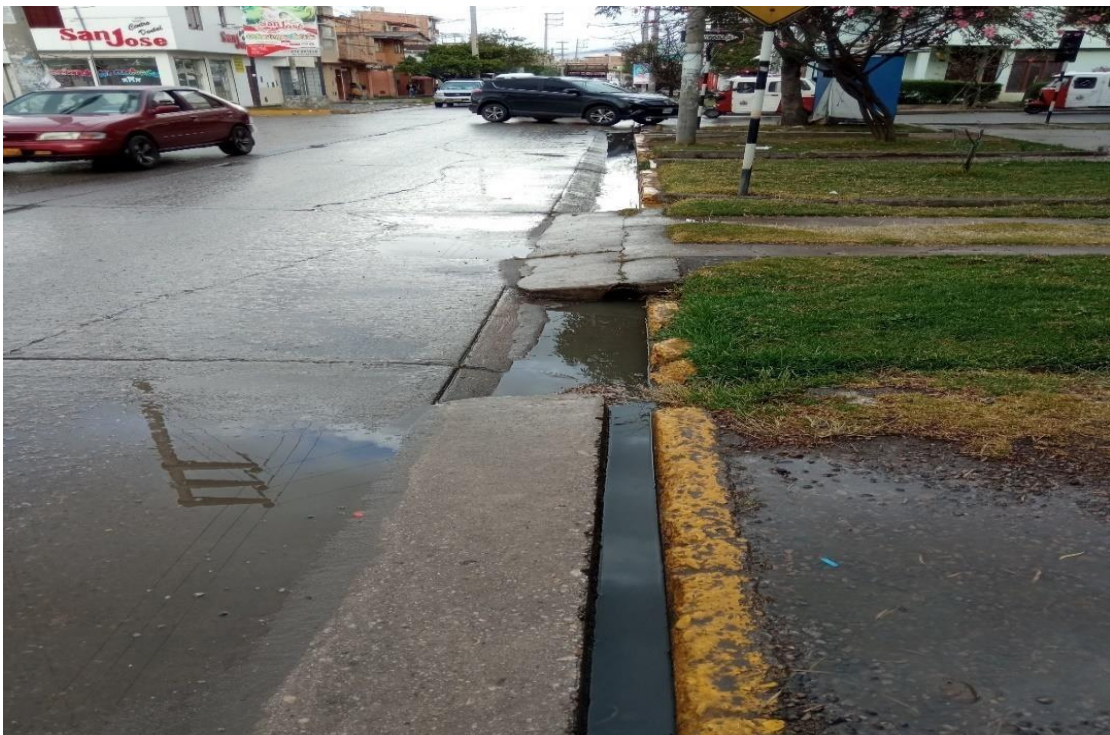
FOTOGRAFÍA N° 10 Construcciones sobre las cunetas para paso vehicular en la cuadra 4 del Jr. Los Sauces – urbanización El Ingenio – Cajamarca.
