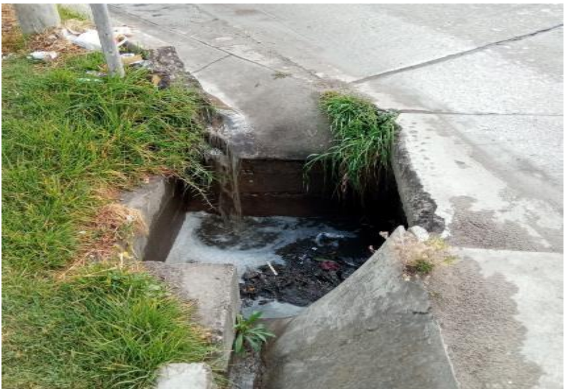
FOTOGRAFÍA N° 8 Colector 2, entre el jirón Los Pinos y Los Sauces – urbanización El Ingenio – Cajamarca.
