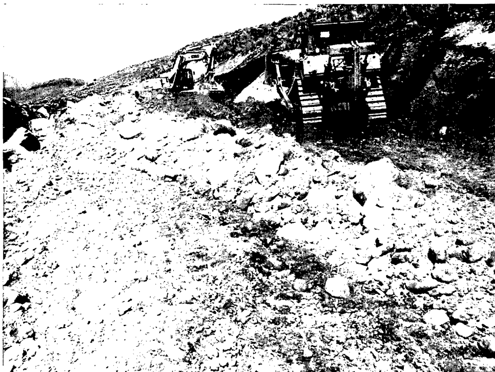
Foto 03: Corte de Material Excedente con Tractor y Excavadora.
