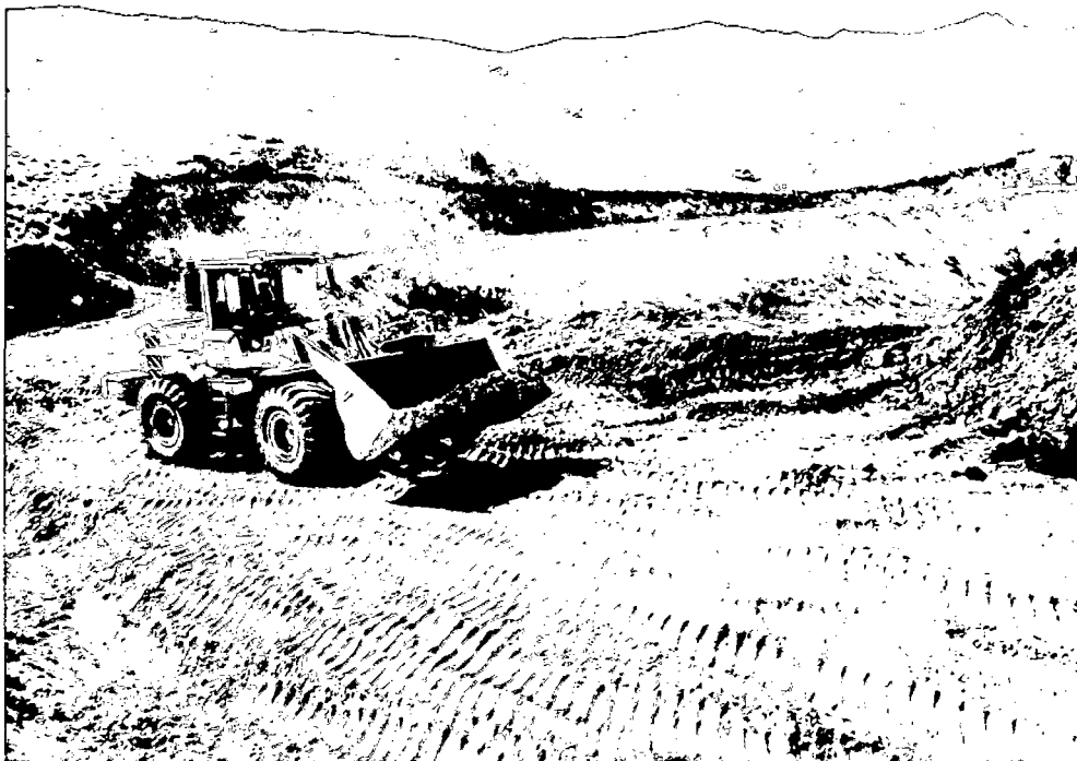
Foto 06: Acopio de material excedente para eliminación
