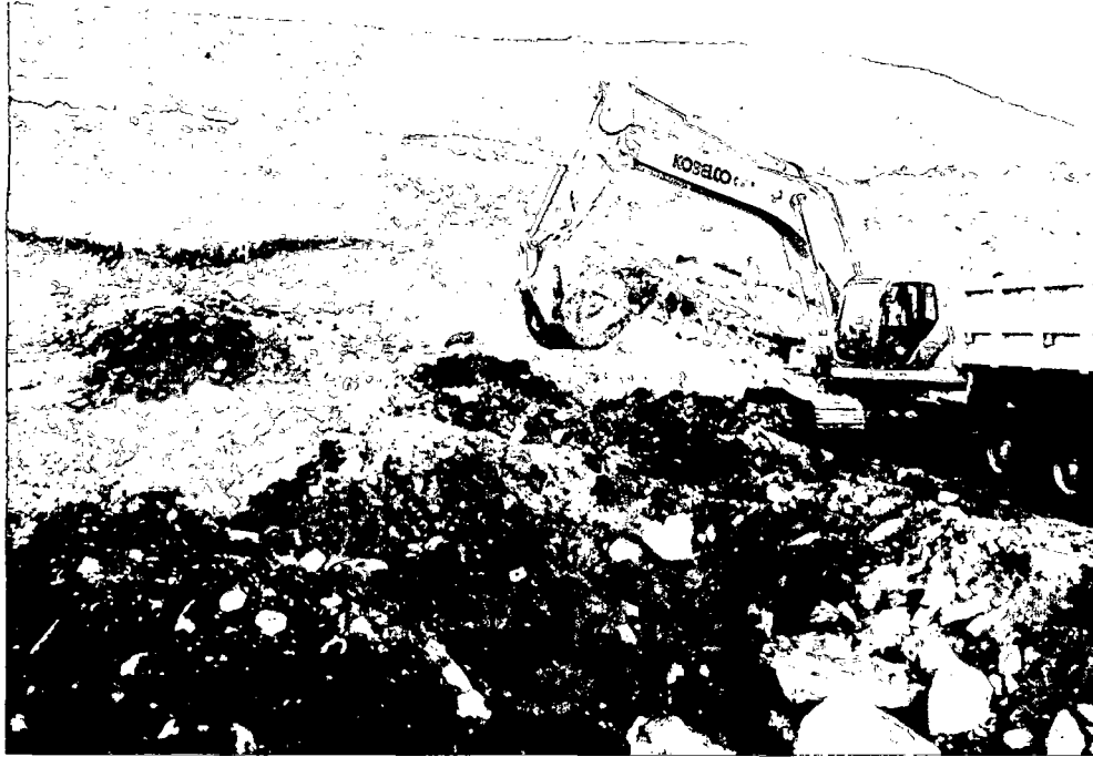
Foto 05: Eliminación de Material Contaminado (Topsoil + Excedente)
