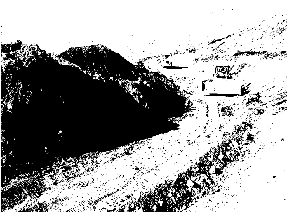
Foto 04: Conformación de acceso para eliminación de Material Orgánico y Excedente.
