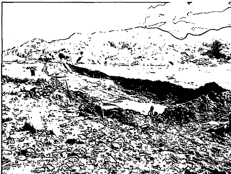
Foto 09: Trazo y Replanteo Topográfico para identificar límites de corte.
