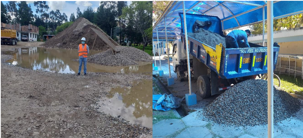
Fotografía N°01: Obtención y traslado del agregado
