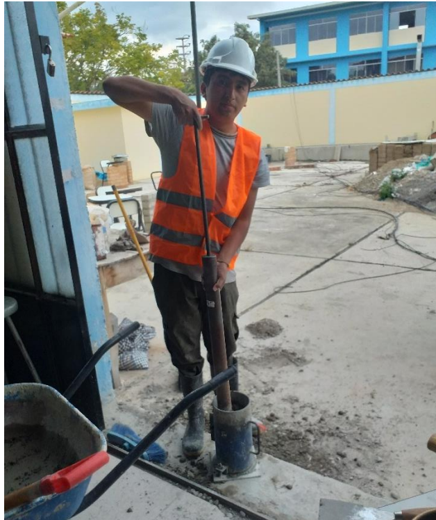
Fotografía N°13: Compactado por capas en elaboración de concreto compactado
