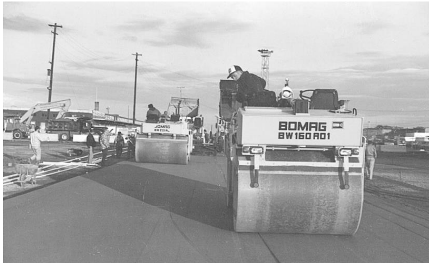
Figura N°01: Compactación con rodillo vibratorio
