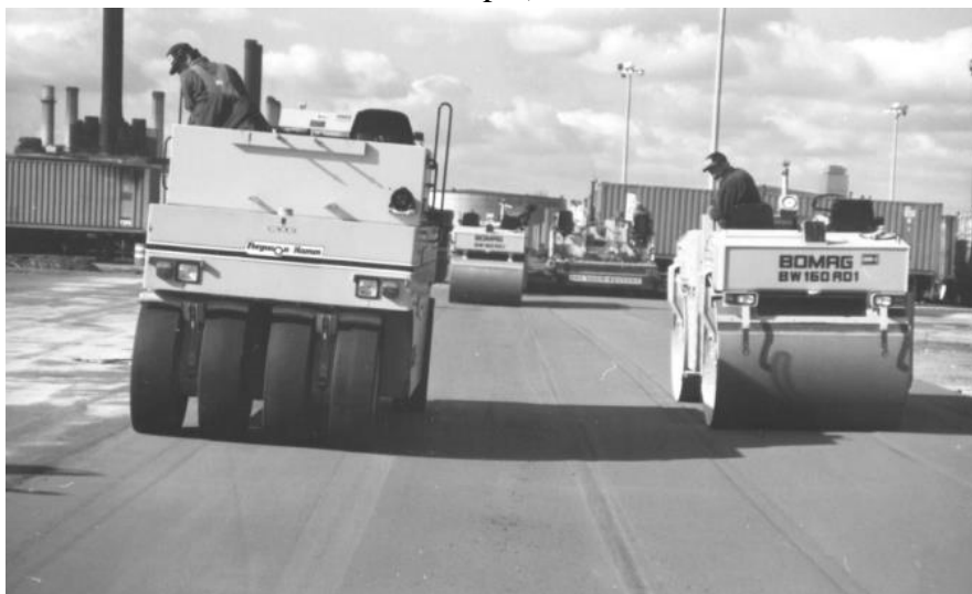
Figura N°02: Compactación con rodillo neumático
