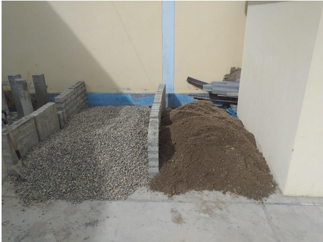
Fotografía N°03: Acopio de agregados
