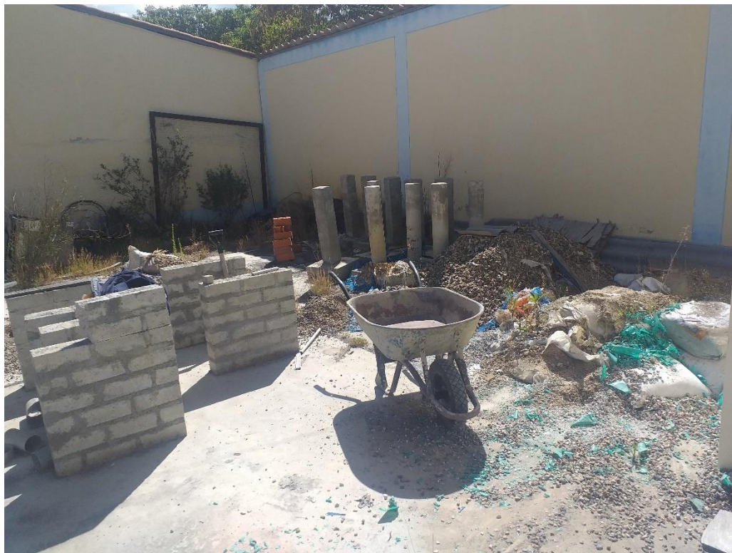
Fotografía N°02: Lugar asignado para acopio de materiales
