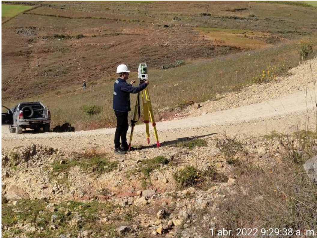
Fotografía N° 11: Día 6 del levantamiento topográfico – nivelación del equipo.
