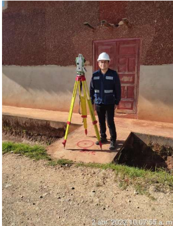
Fotografía N° 13: Día 7 del levantamiento topográfico – pintado con aerosol de punto BM..
