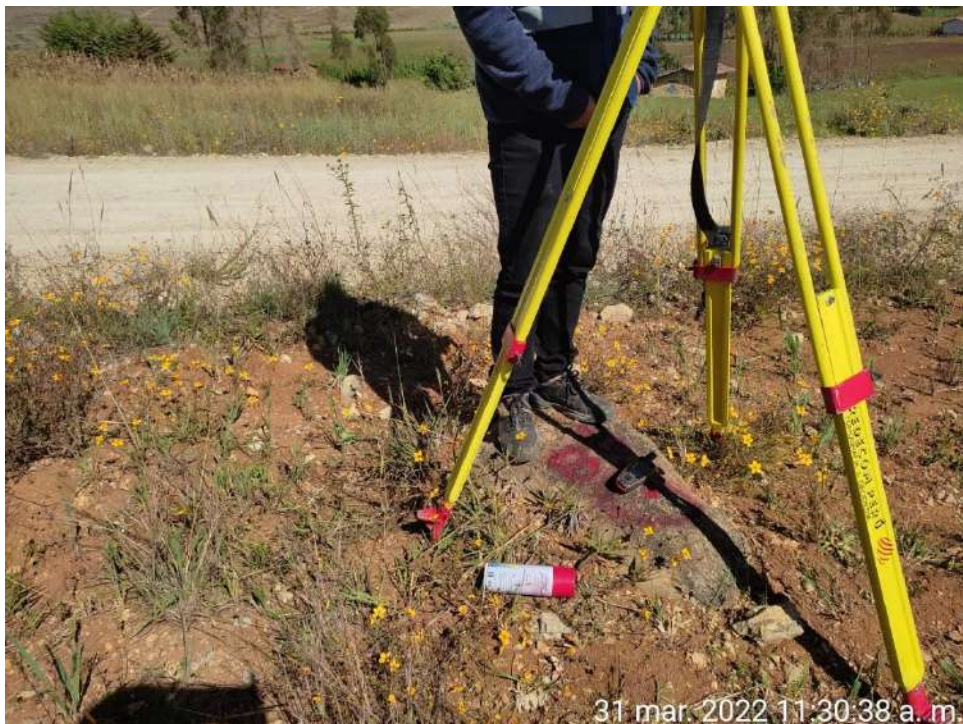
Fotografía N° 10: Día 5 del levantamiento topográfico – pintado de estación.
