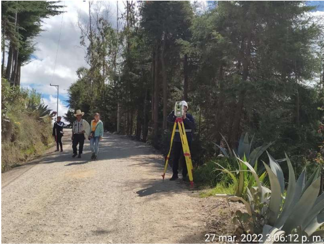
Fotografía N° 3: Día 1 del levantamiento topográfico, visado de puntos de la sección de carretera.
