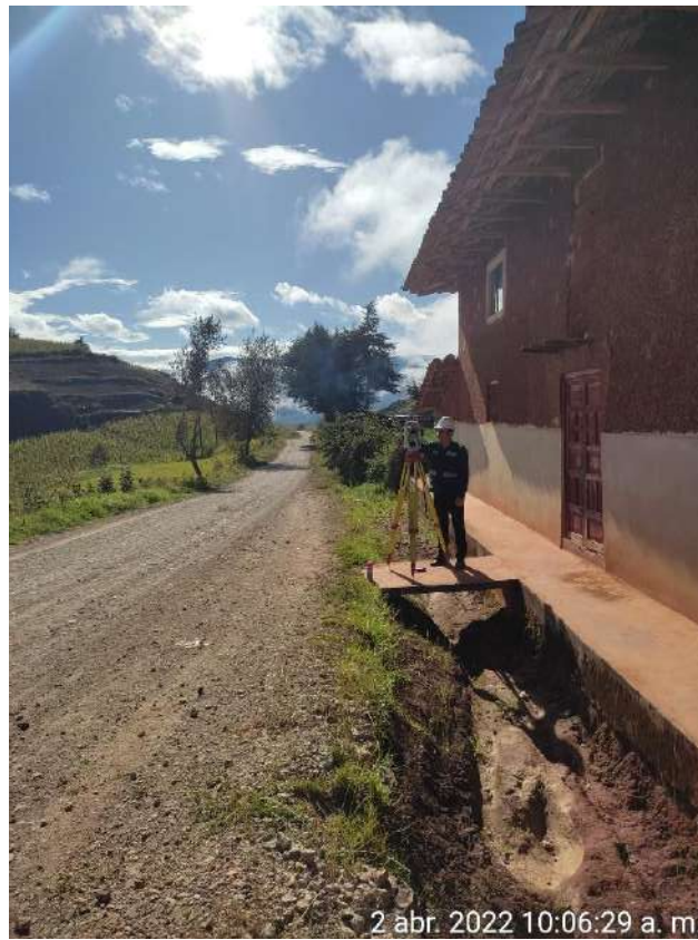
Fotografía N° 12: Día 7 del levantamiento topográfico - nivelación de equipo.
