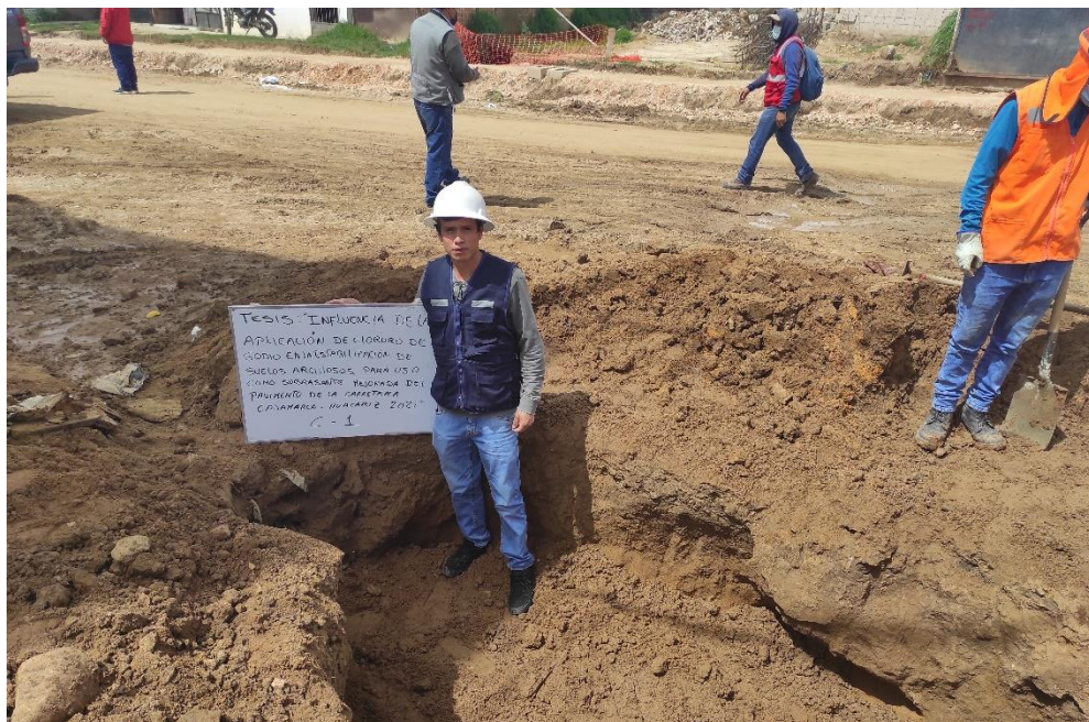
Figura 12: Extracción de material de calicata C01 para la elaboración de tesis
