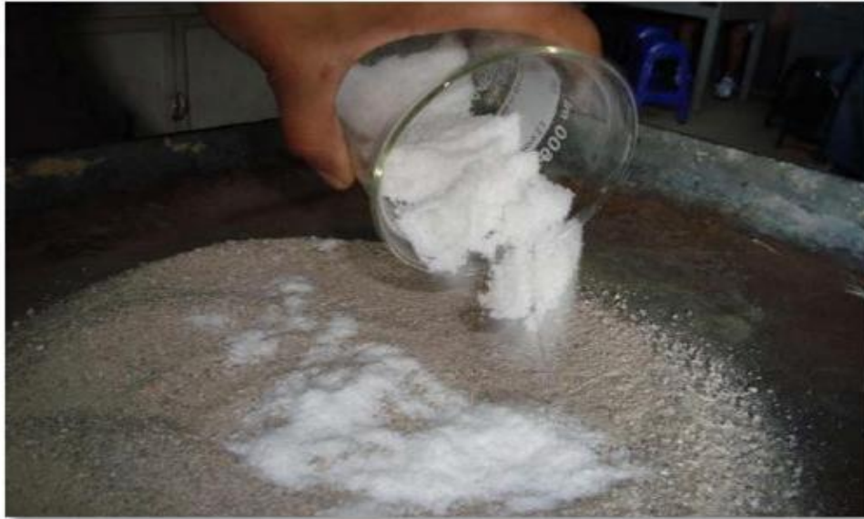
Figura 3: Aplicación de cloruro de sodio en grano Fuente: Roldan, 2010
