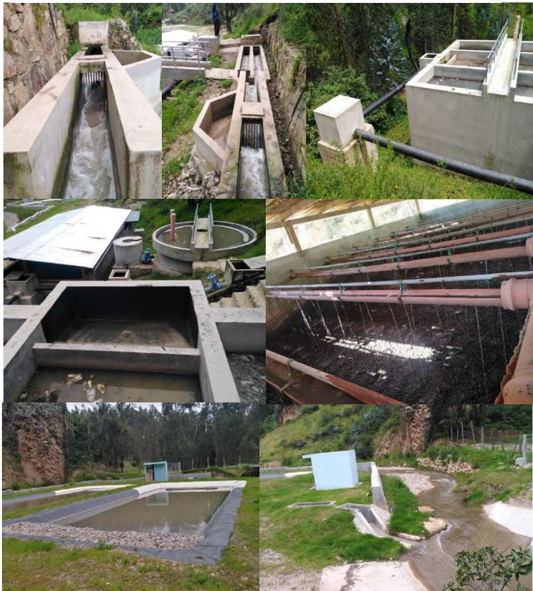
ANEXO N° 10. Panel fotográfico de la planta de tratamiento de aguas residuales de Contumazá
