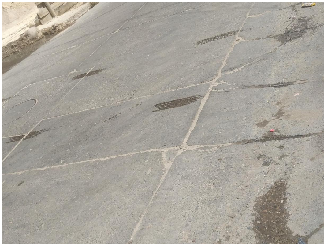
Fotografía 16. Descascaramiento de junta (19)
