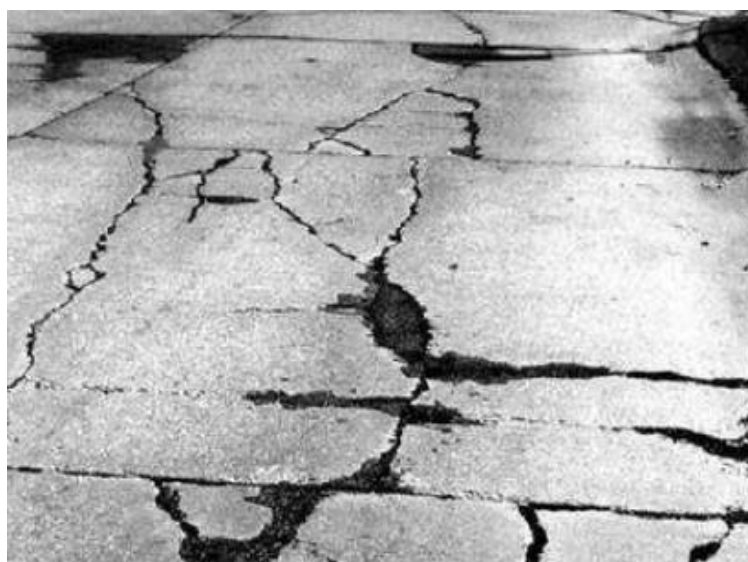
Figura 3. Losa dividida.
