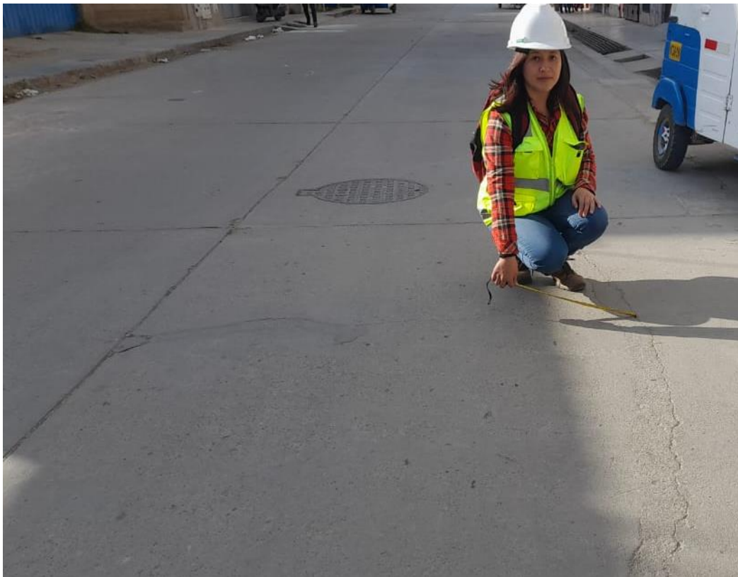
Fotografía 6. Daño en el sello de junta (06)
