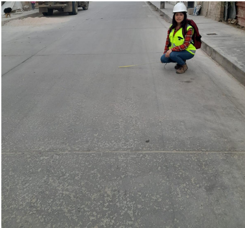
Fotografía 14. Fisuras de contracción (17)
