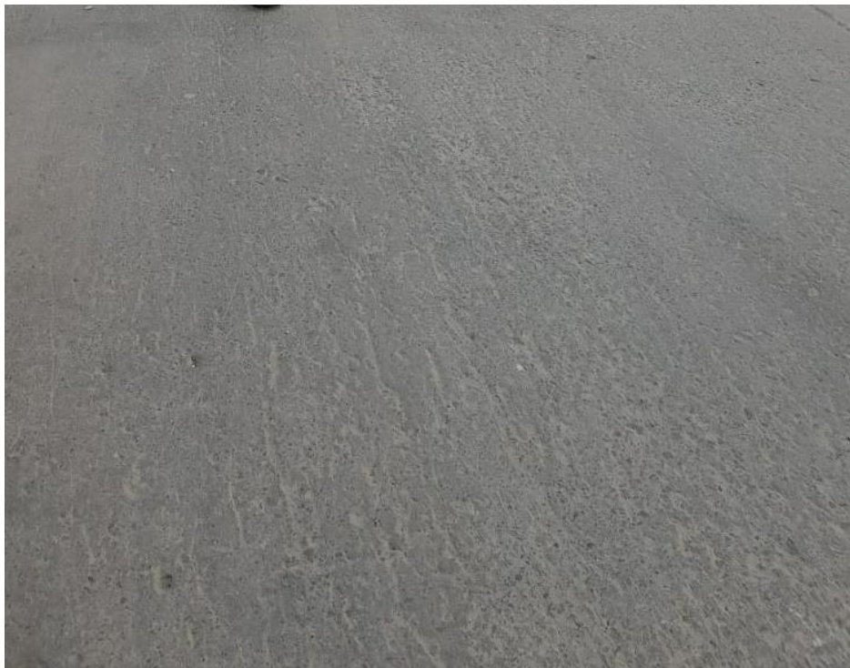
Fotografía 14. Fisuras de contracción (17)
