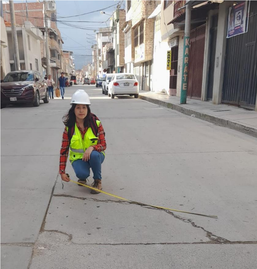
Fotografía 4. Fisura de esquina (02)
