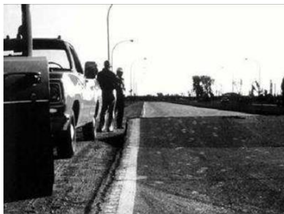
Figura 1. Levantamiento/pandeo.
