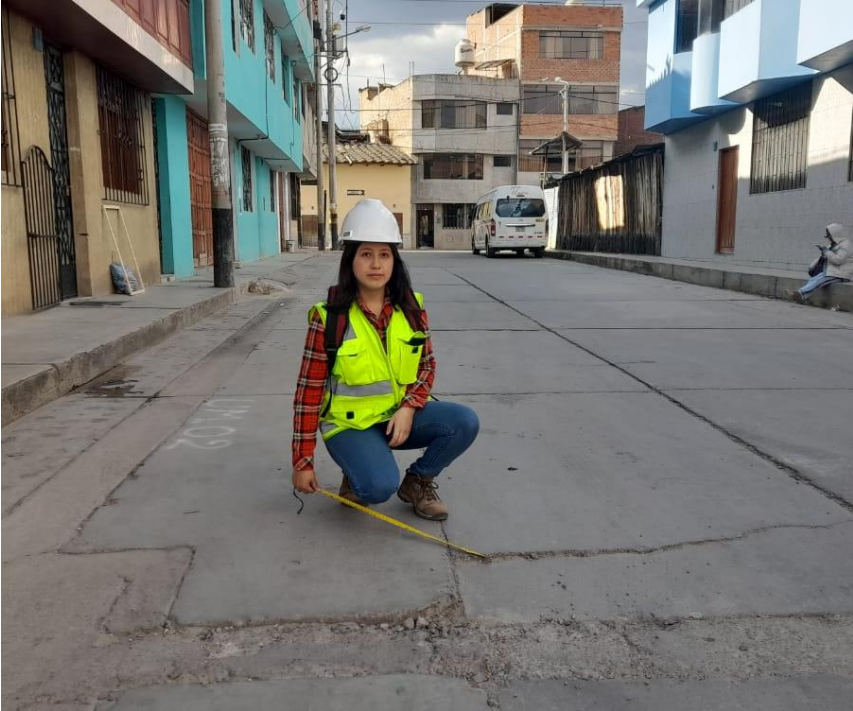
Fotografía 4. Fisura de esquina (02)
