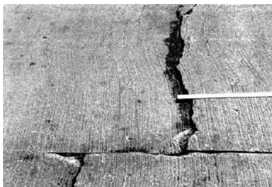
Figura 5. Fisuras lineales.
