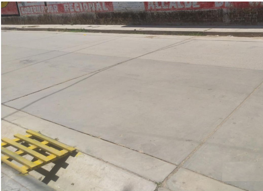
Fotografía 6. Daño en el sello de junta (06)
