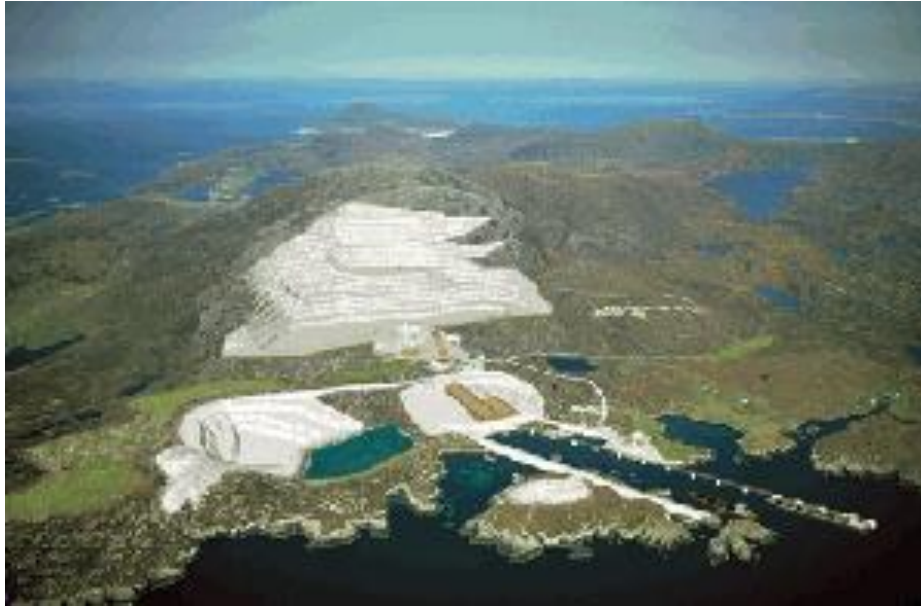
Figura 8. Cantera en ladera
