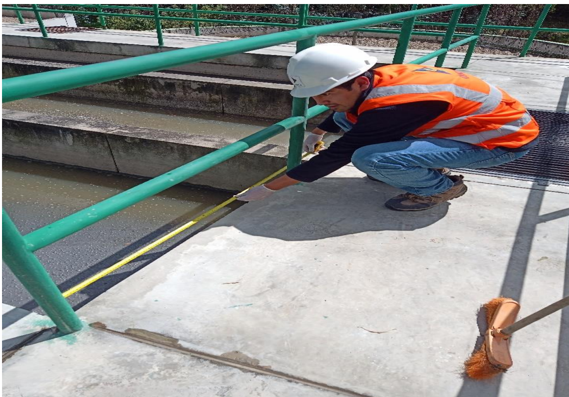
Figura 29: Medición de la zona de ventilación del tanque Imhoff
