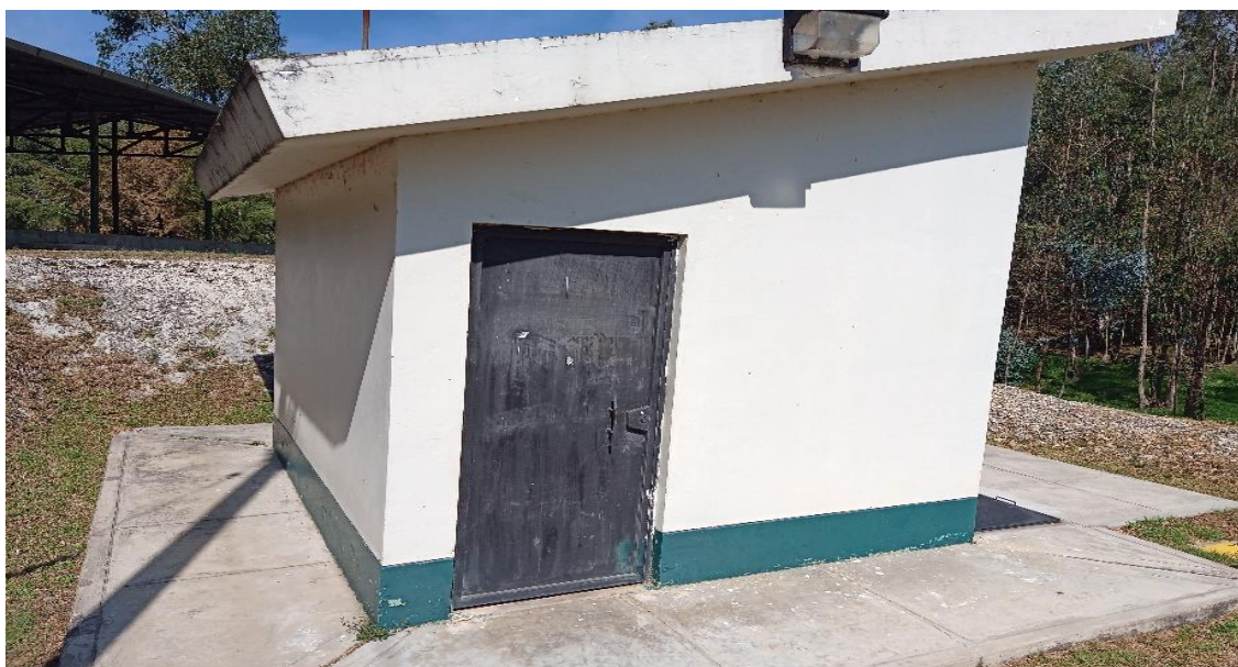
Figura 40: Caseta de desinfección
