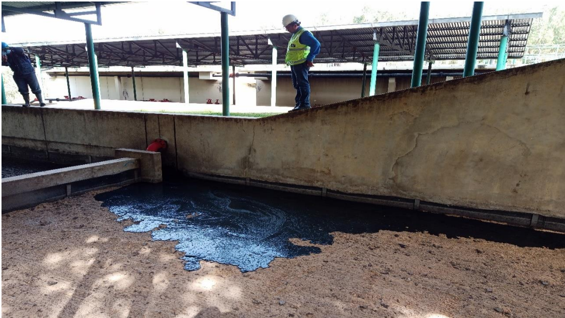
Figura 58: Vertimiento del lodo en el lecho de secado
