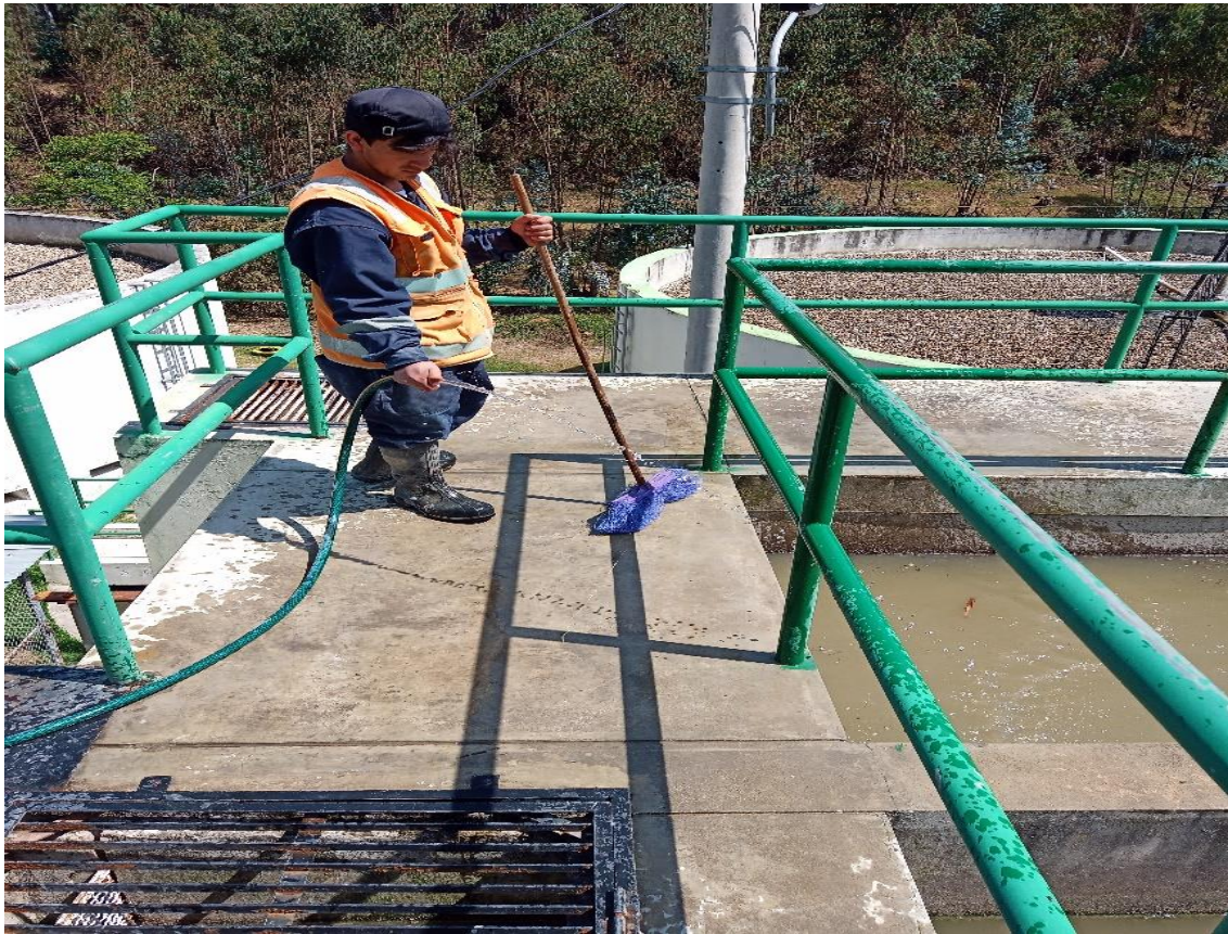
Figura 53: Lavado de la zona por donde se transita en el tanque Imhoff
