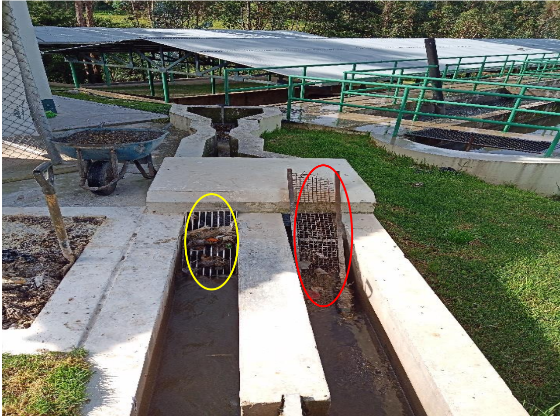
Figura 22: Sistema de cribas
