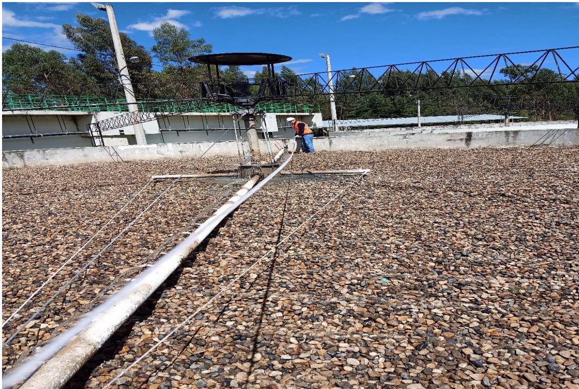
FOTOGRAFÍA N°09: Medición del diámetro del filtro percolador
