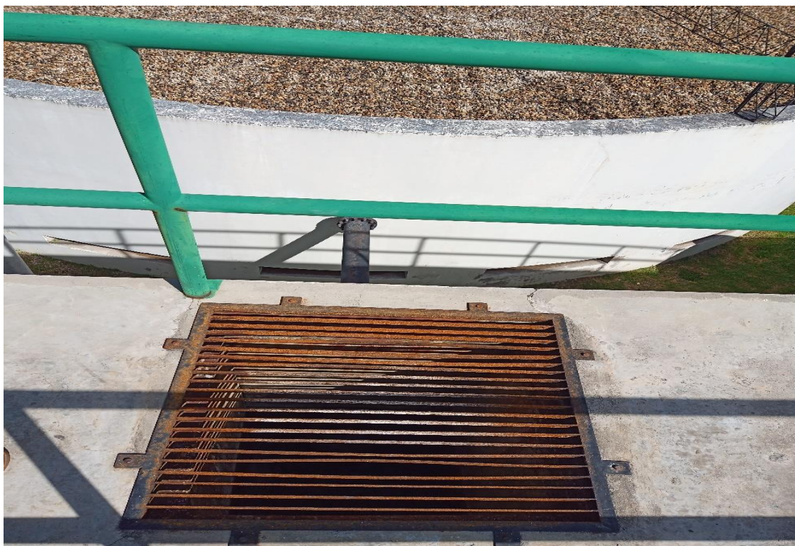
Figura 51: Cámara de reunión que conecta inmediatamente con el filtro percolador
