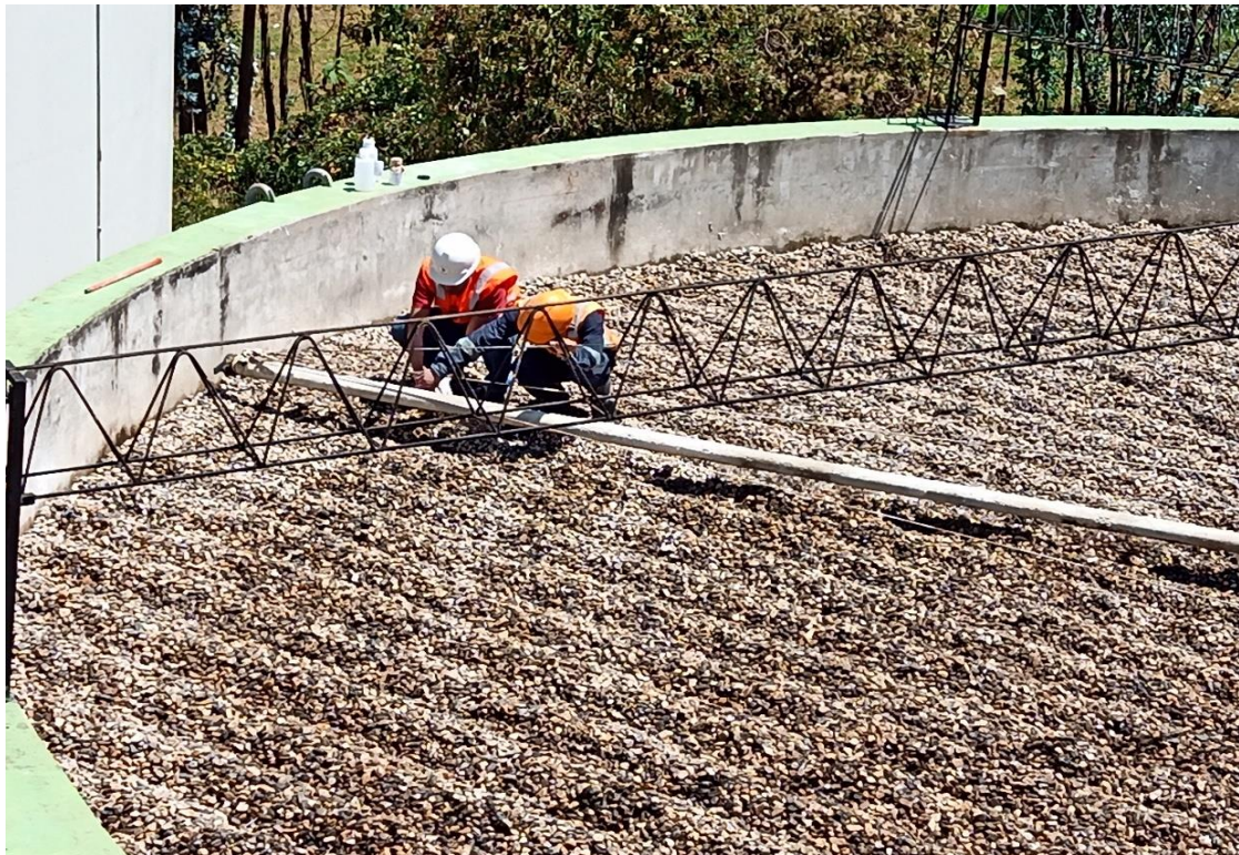
FOTOGRAFÍA N°02: Toma de muestra al inicio en el filtro percolador
