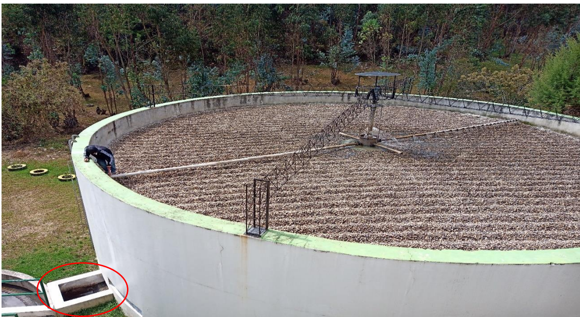
Figura 55: Orientación del brazo mecánico y caja de reunión
