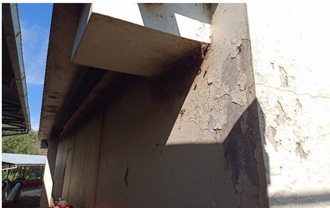
Figura 35: Esquina sur del tanque Imhoff N°02
