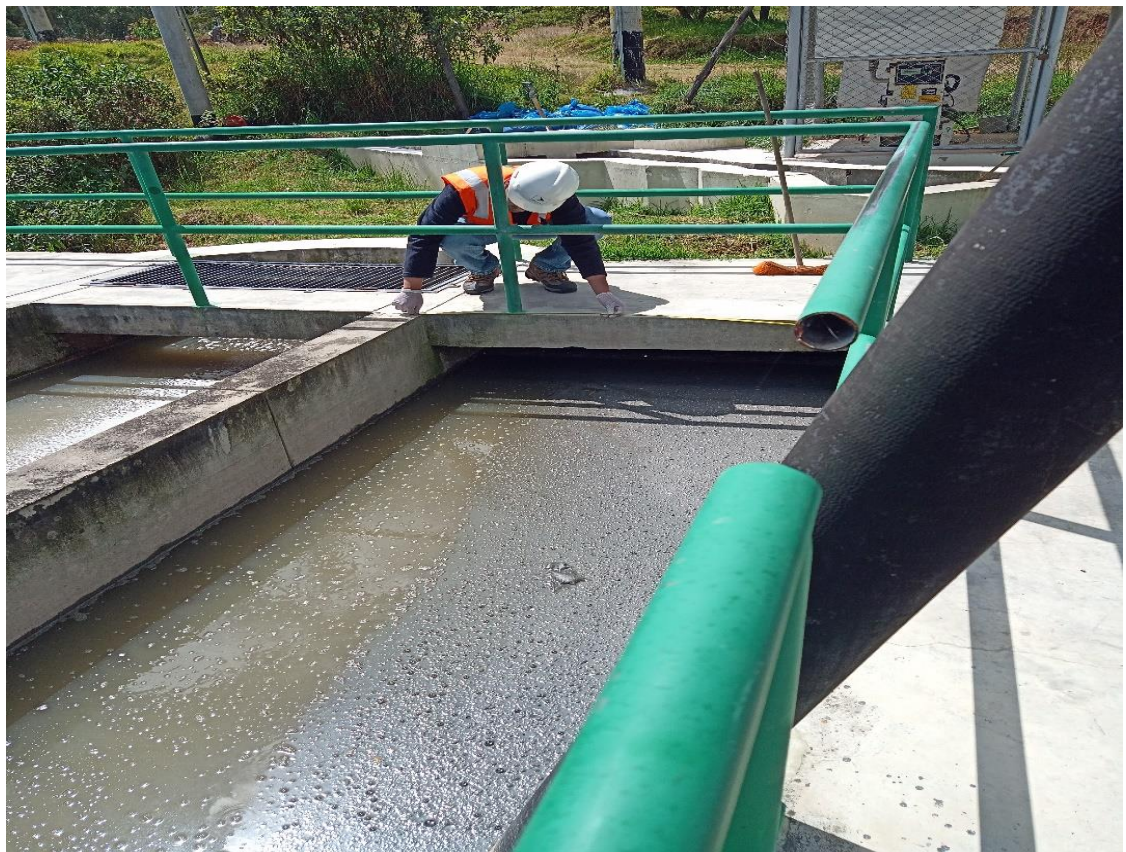
FOTOGRAFÍA N°10: Medición de dimensiones del tanque Imhoff
