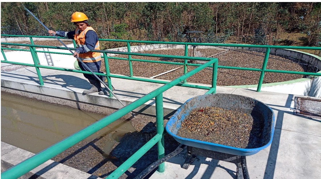
Figura 52: Limpieza de natas y sólidos
