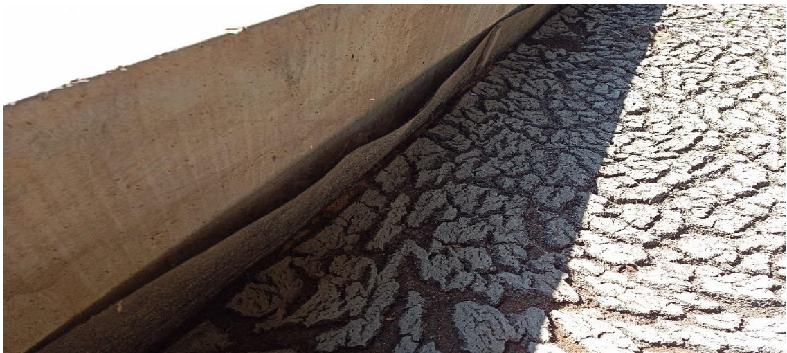
Figura 44: Uso de geomembrana en la pared de los lechos de secado
