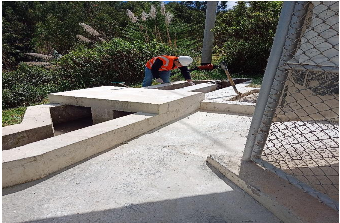
Figura 21: Medición de las dimensiones del by pass
