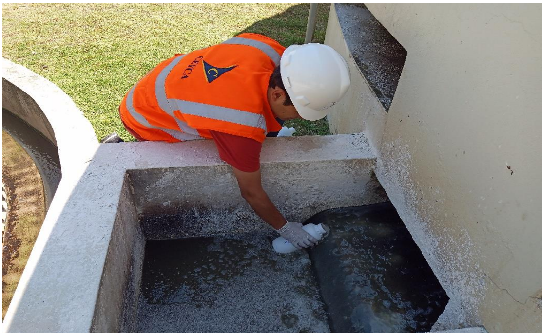
FOTOGRAFÍA N°03: Toma de muestra a la salida del filtro percolador
