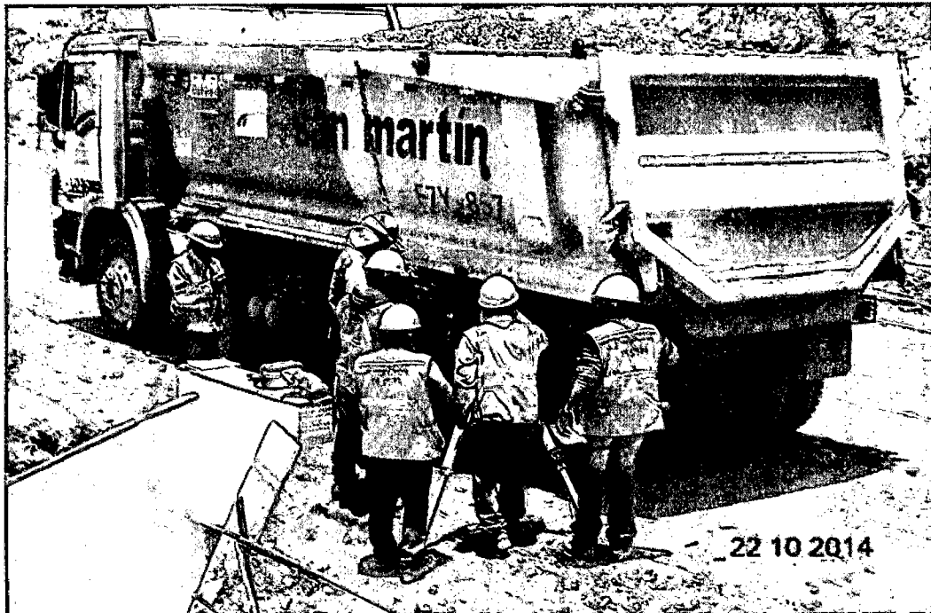
Figura 43: colocación del camión cargado para la prueba de junta al borde lateral (zona de empalme modulo-cabezal)
