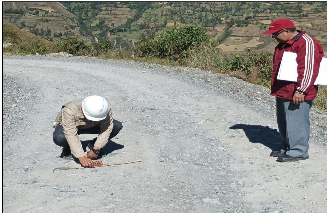
Figura N° 49. Medición del peralte de la curva horizontal (C-88) en campo.
