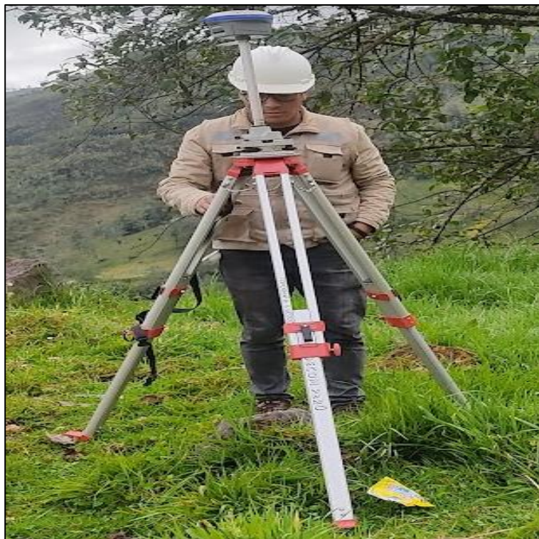
Figura N° 37. Estacionamiento y nivelación del GPS diferencial.
