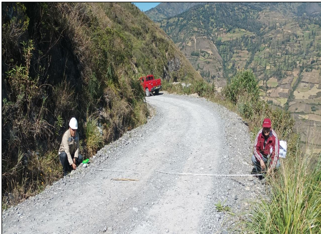
Figura N° 41. Ancho de la plataforma o corona.
