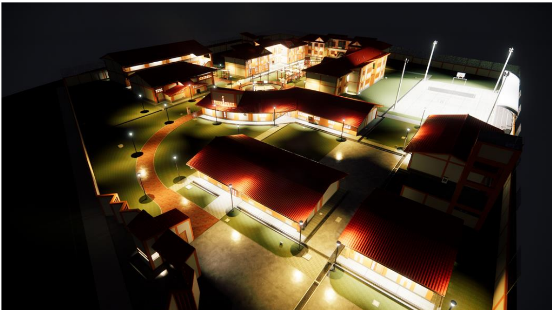
Figura N° 110: Vista Aérea Nocturna de la Aldea Infantil San Antonio - Cajamarca
