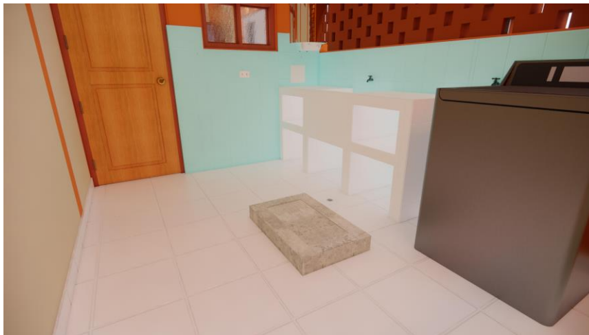
Figura N° 88: Error en la cota de tapa de la caja de registro de la Lavandería del Módulo de Vivienda
