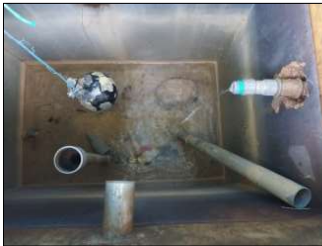
Figura N°8. CRP 2, presencia de sarro y accesorios en mal estado.
