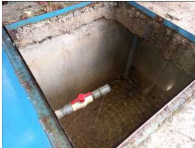
Figura N°8. CRP 2, presencia de sarro y accesorios en mal estado.
