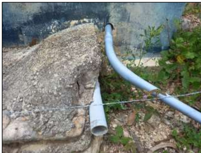
Figura N°6. Curvatura no adecuada para el funcionamiento.
