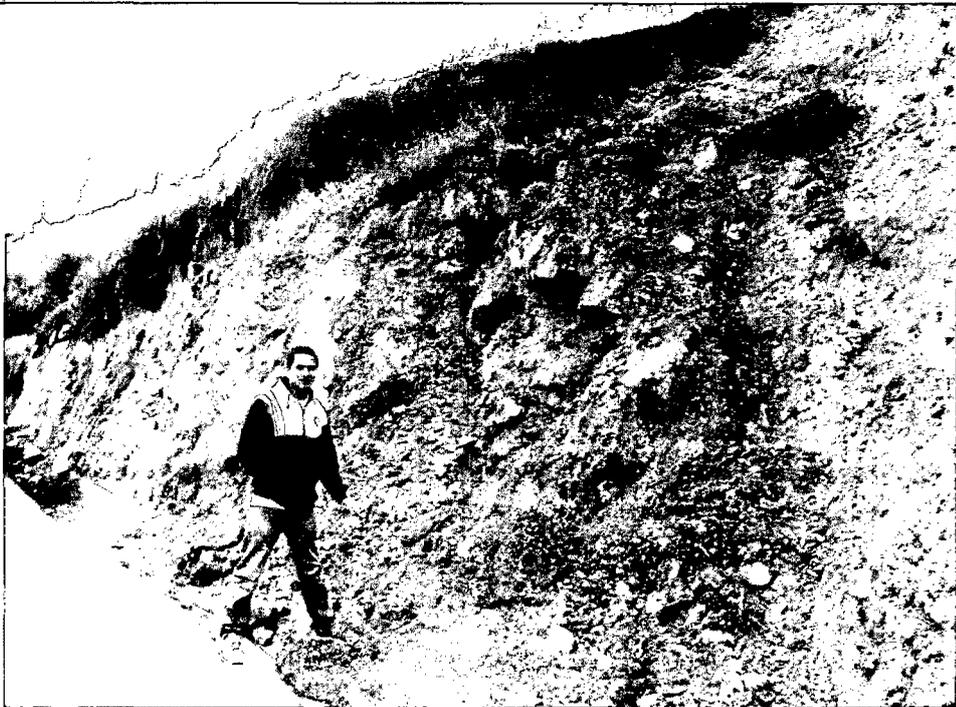
**Fotografía N° 4. Se exhibe la caída de material rocoso y tierra sobre la sección hidráulica de la cuneta.**
