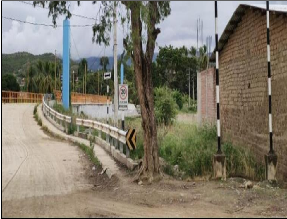
Figura 40. Entrada a la localidad Bellavista viejo y alrededores, viviendas construidas con adobe principalmente.
