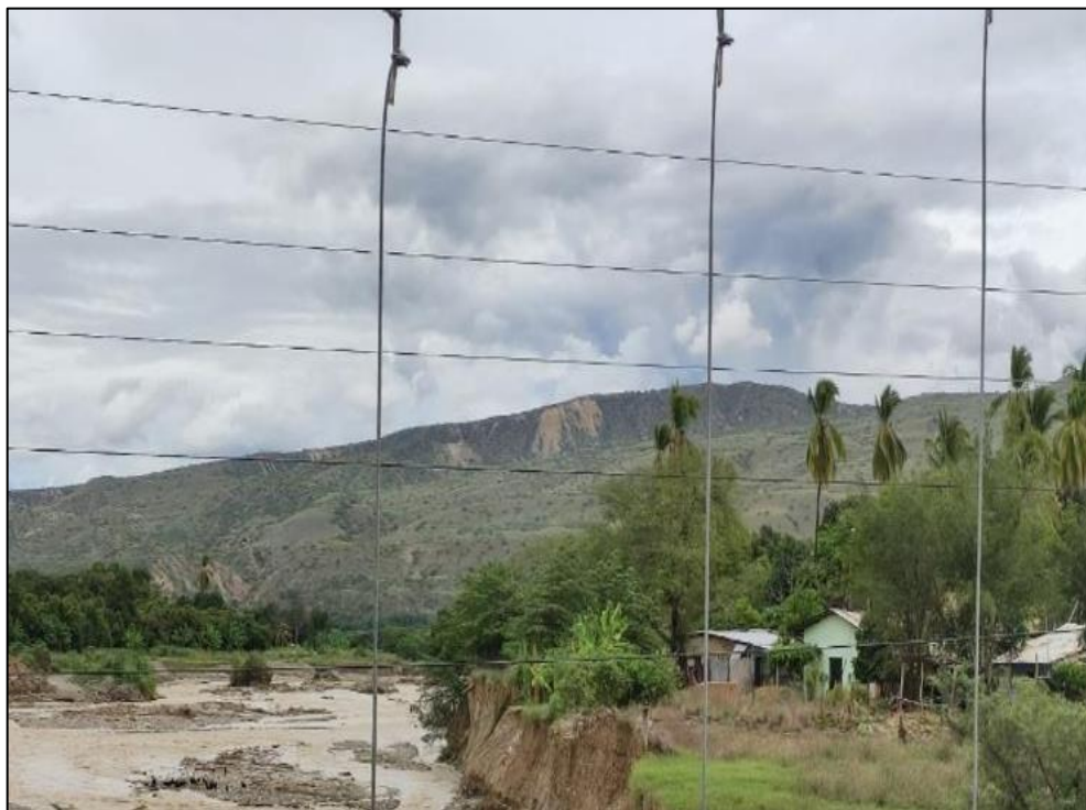
Figura 39. Zonas erosionadas por la fuerza hidrodinámica del agua y viviendas cercas en peligro muy alto.
