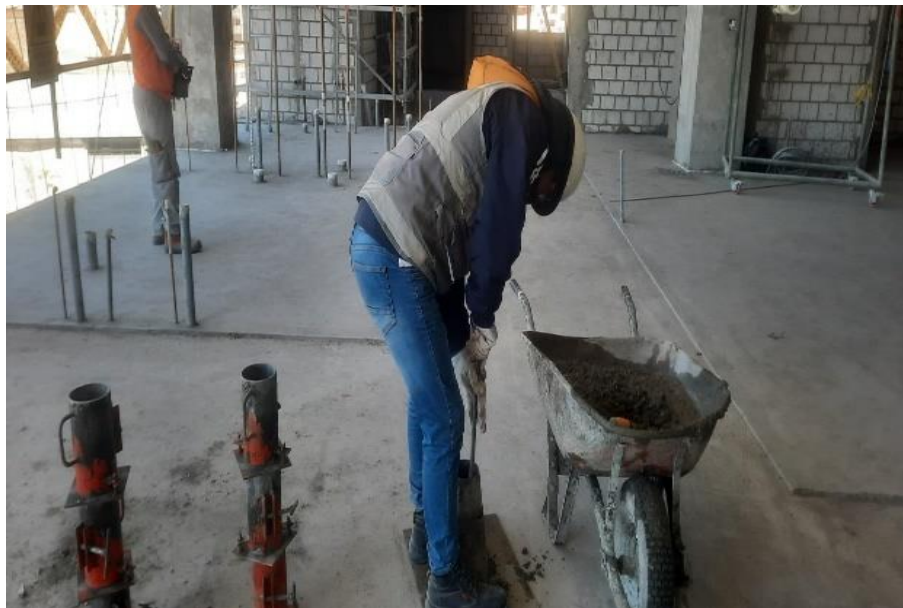
Fotografía N°04. Prueba de asentamiento antes del vaciado del elemento estructural muros.
