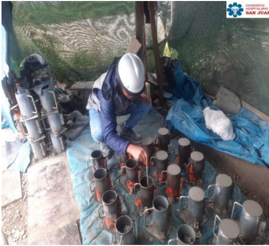
Fotografía N°09. Elaboración de testigos de concreto para cada elemento estructural.
