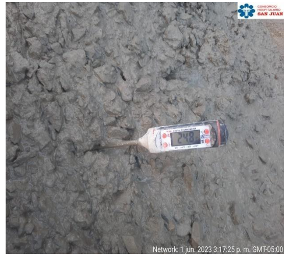
Fotografía N°08. Resultado de temperatura antes del vaciado del elemento estructural.
