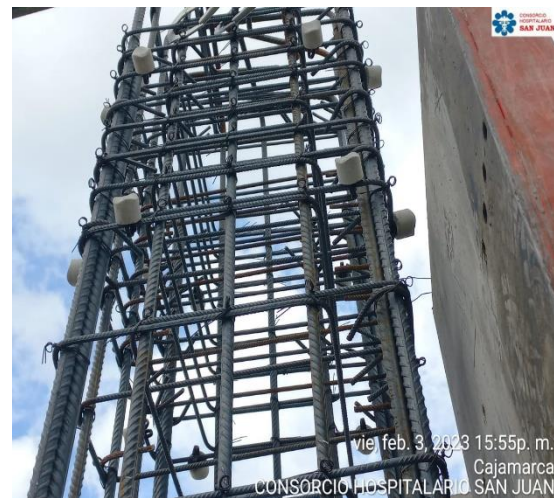
Fotografías 19 y 20. Verificación de la correcta distribución de los dados de concreto para garantizar el adecuado recubrimiento del encofrado.
