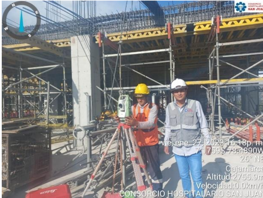
Fotografía N°18. Verificación de los trazos de columnas con estación total. correcta nivelación
