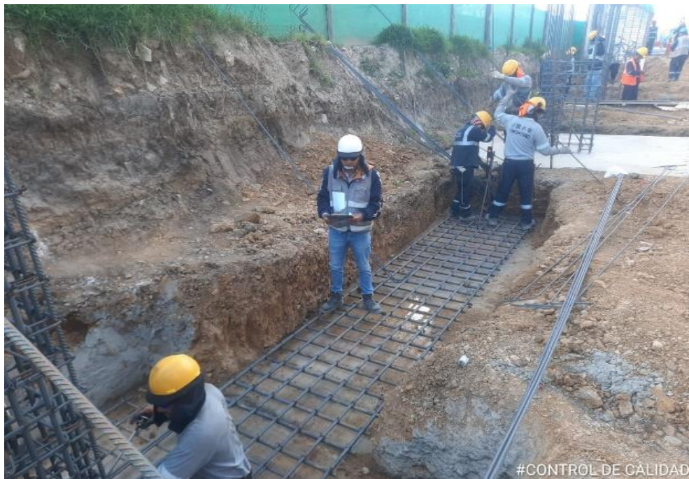
Fotografía N°25. Verificación de la correcta del acero inferior en vigas de cimentación.
