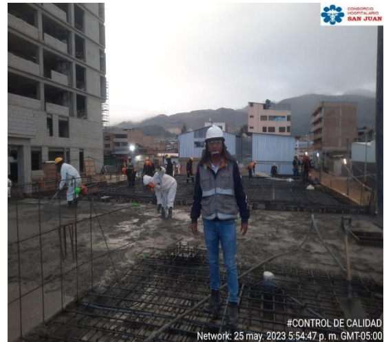
Fotografía 21. Verificación de elementos incorporados, pases para instalaciones eléctricas, instalaciones sanitarias, otros.
