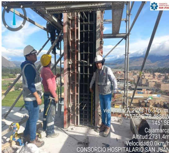
Fotografía N°14. Verificación de la correcta distribución de acero en el elemento (columnas).
