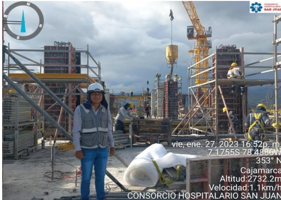
Fotografía N°16. Se llevó a cabo la verificación de la correcta vibración del concreto.
