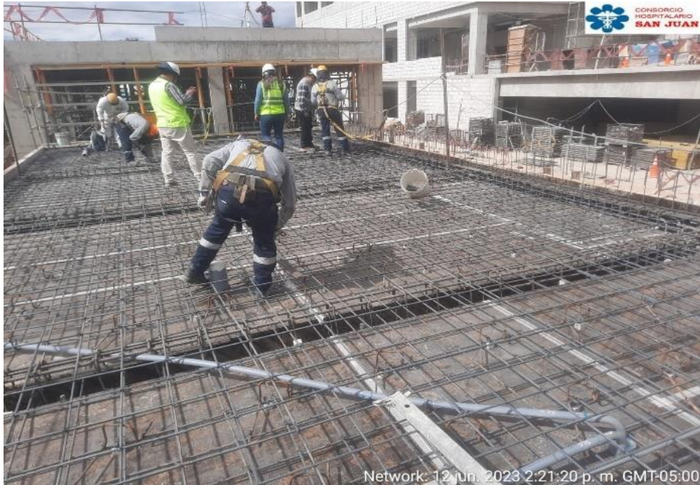
Fotografía 21. Verificación de elementos incorporados, pases para instalaciones eléctricas, instalaciones sanitarias, otros.
