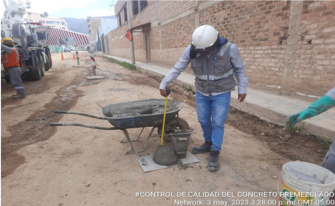
Fotografía N°01. Prueba de asentamiento antes del vaciado de los elementos estructurales.
