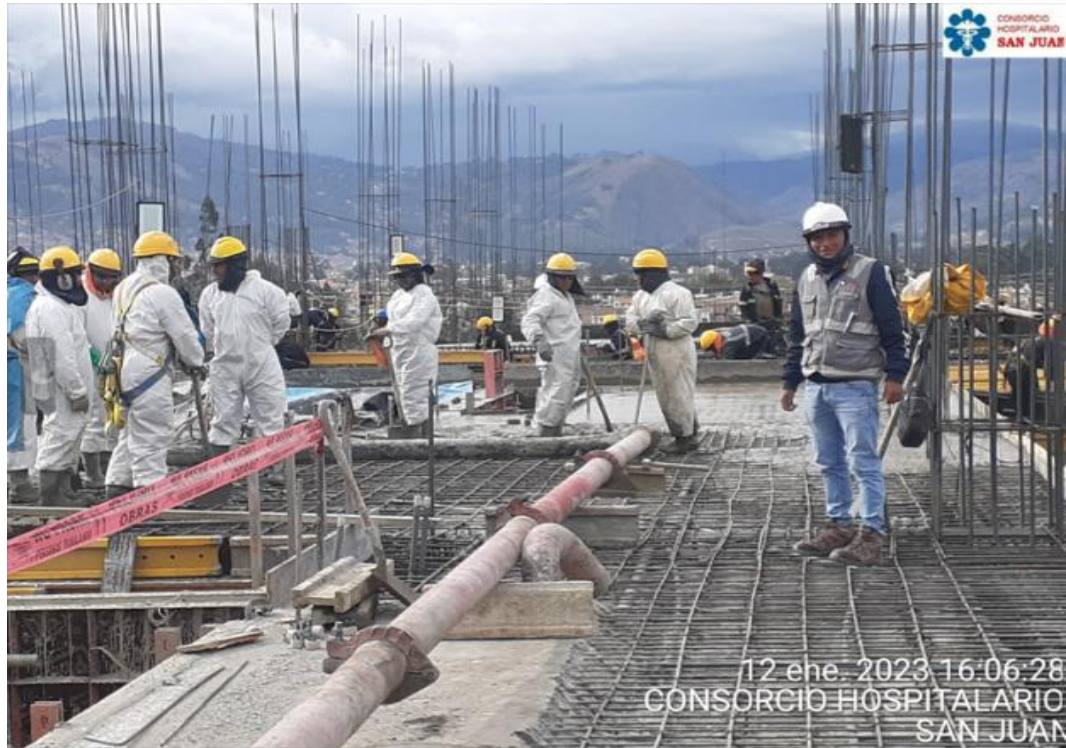
Fotografía N°26. Verificación del proceso de vertido del concreto.
