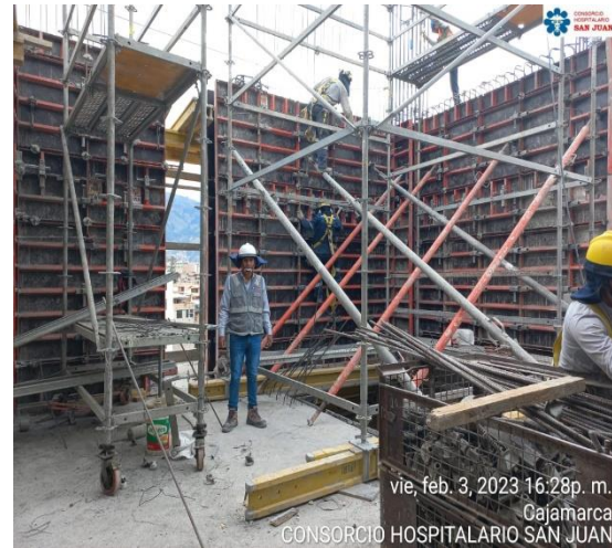
Fotografía N°15. Verificación de la correcta distribución de acero en el elemento (placas).
