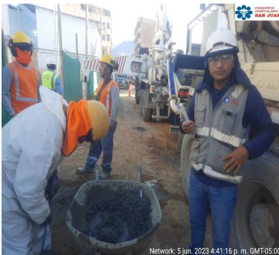
Fotografía N°07. Prueba de asentamiento y temperatura antes del vaciado del elemento estructural.
