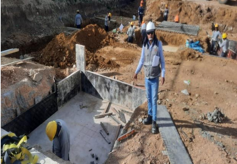
Fotografía N°24. Se llevó a cabo la verificación del trazo para columnas.
