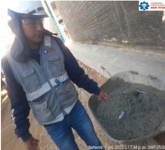
Fotografía N°05. Prueba de temperatura antes del vaciado del elemento estructural.
