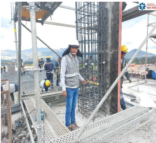
Fotografías 19 y 20. Verificación de la correcta distribución de los dados de concreto para garantizar el adecuado recubrimiento del encofrado.
