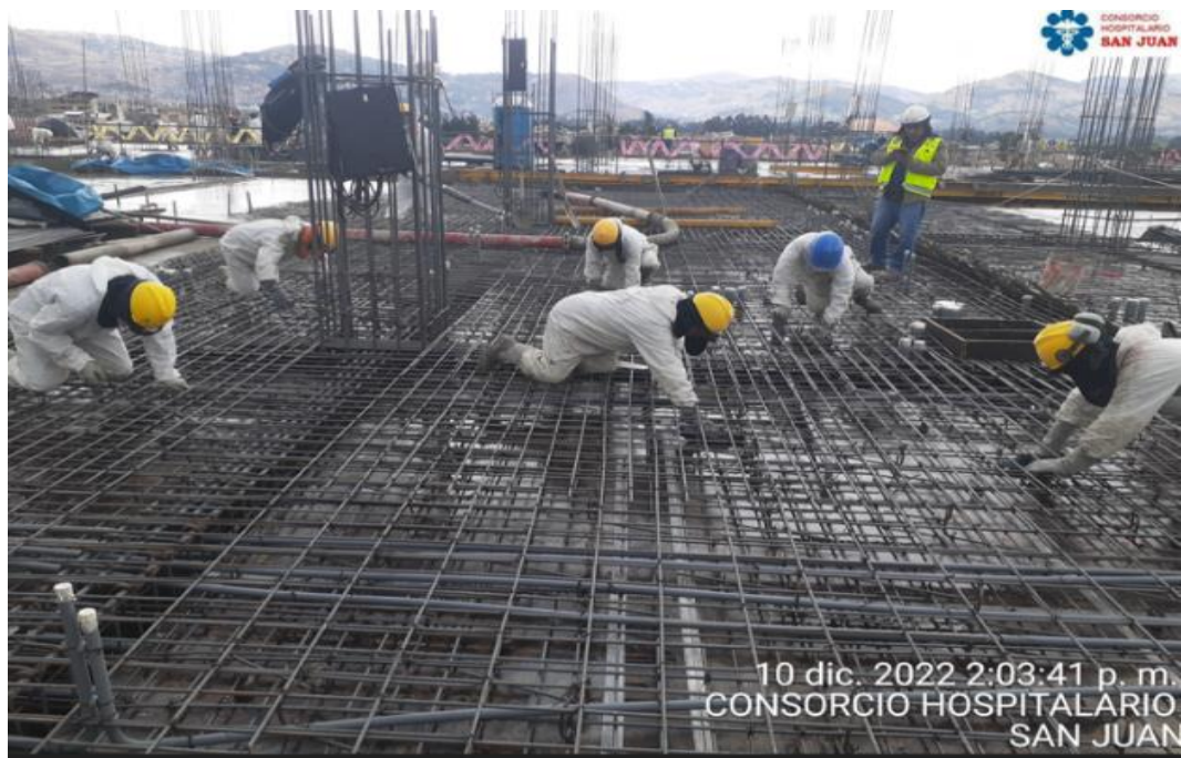
Fotografía N°27. Verificación de la limpieza del fenólico antes del vertido.
