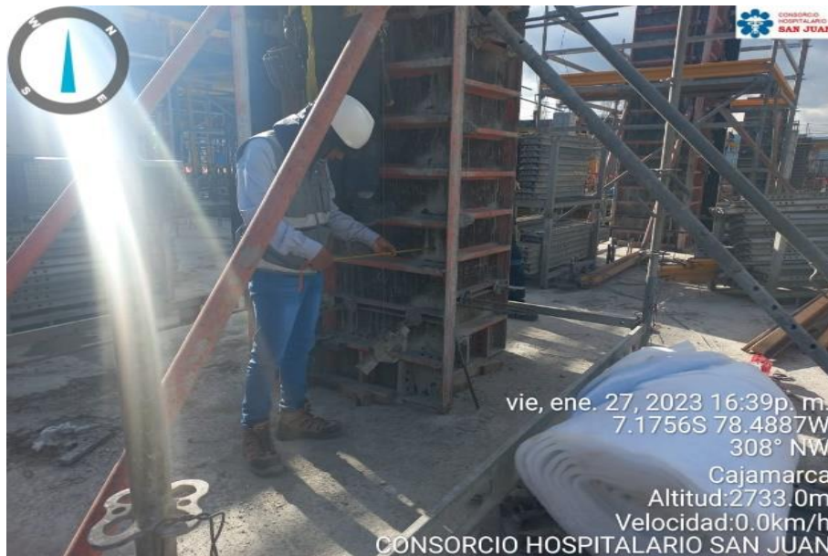
Fotografía N°17. Verificación de la correcta nivelación del encofrado del elemento (columnas).
