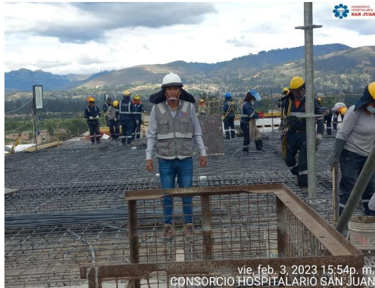
Fotografía N°13. Verificación de la correcta distribución de acero y limpieza del fenólico antes del vertido.
