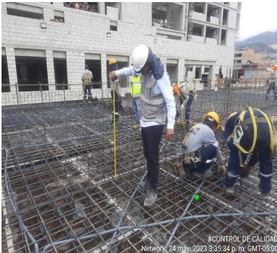
Fotografía 21. Verificación de elementos incorporados, pases para instalaciones eléctricas, instalaciones sanitarias, otros.
