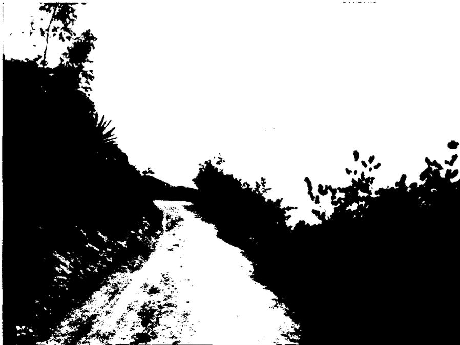
*FOTO N° 06.- Se muestra el estado de la carretera, sin presencia de cunetas en algunos tramos.*
