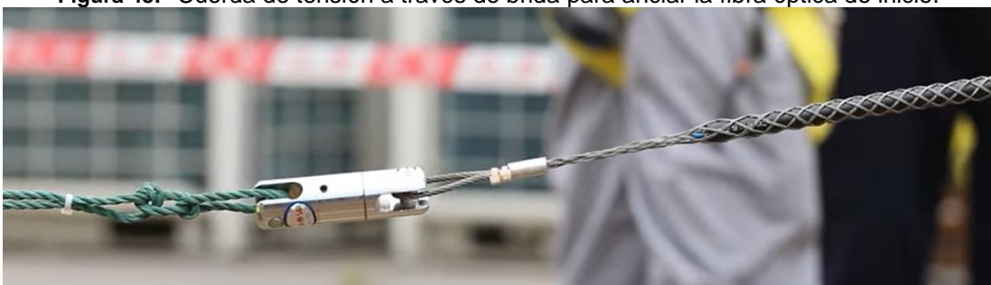
Figura 48: Cuerda de tensión a través de brida para anclar la fibra óptica de inicio.
