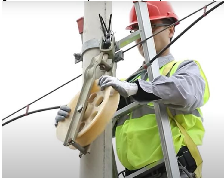
Figura 49: Instalación de polea de inicio para pasar la fibra óptica.
