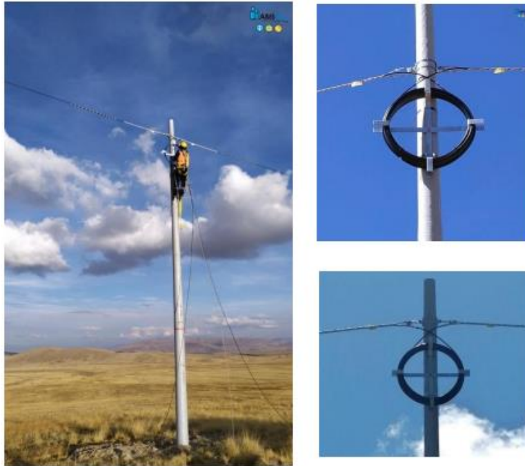
Figura 56: Instalación de crucetas
