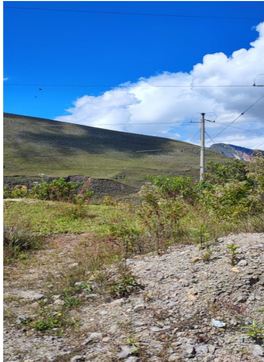
Figura 26: Torre MT Villa Cantange.
