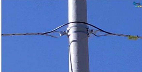
Figura 59: Herraje de retención (preformado), para vanos de 200 – 400 m.
