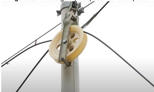
Figura 50: Polea guía para pasar la fibra óptica.
