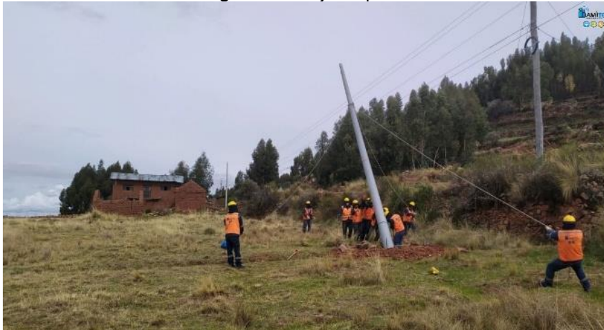
Figura 43: Izaje de poste
