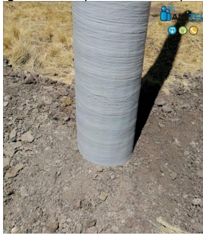
Figura 42: Empotramiento de poste
