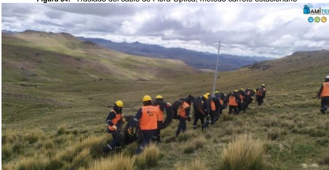
Figura 54: Traslado del cable de Fibra Óptica, método carrete estacionario
