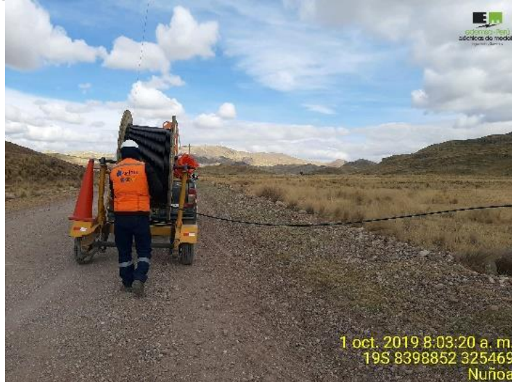
Figura 46: Método de carrito móvil, para el tramo Celendín - Sucre
