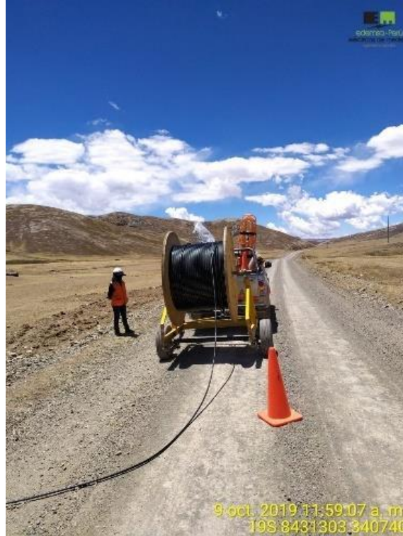
Figura 47: Otra vista del método de carrete móvil
