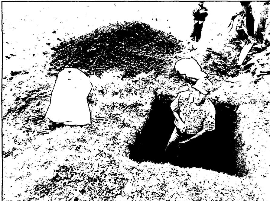
FOTOGRAFÍA N°09: Excavación de una de las calicatas para el estudio de suelos de la zona en estudio.
