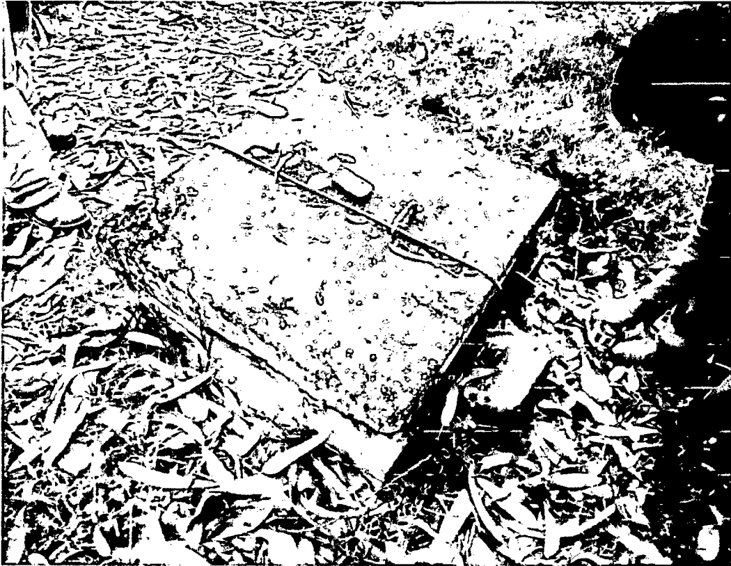
Fotografía N° 05: Cámara Rompe Presión Tipo 6-N°02 (CRP6-02) (Tomando medidas a la estructura existente)
