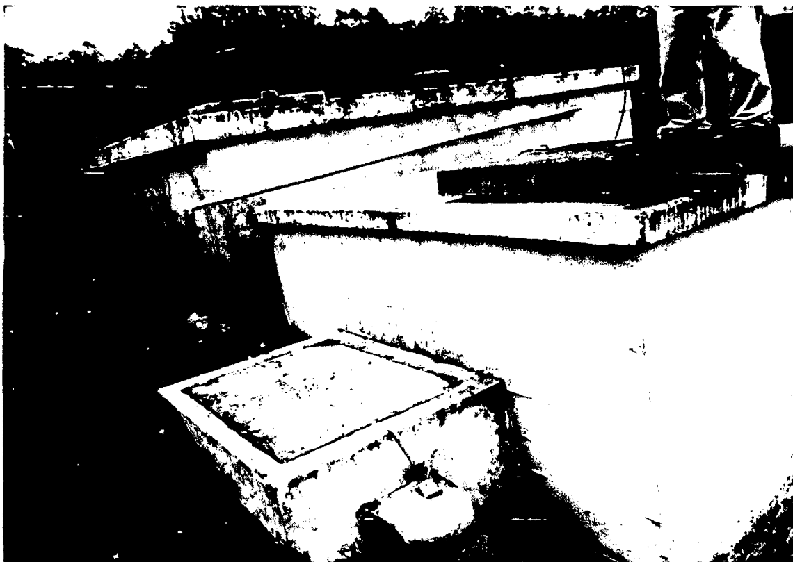
Fotografía N° 07: Cámara de válvulas existe de reservorios (Estructura a demoler y reemplazar)
