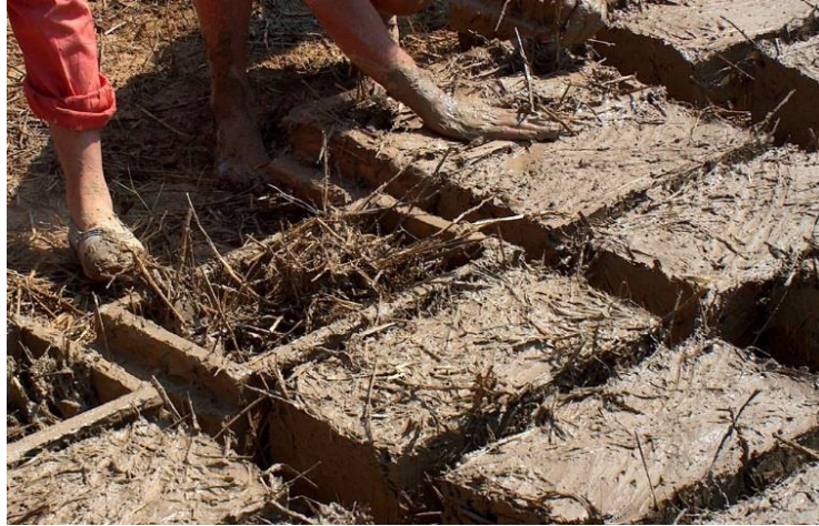
Figura 7: Construcción del adobe.
