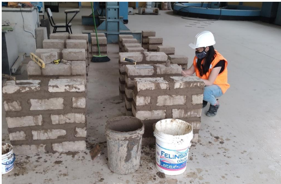
Figura 23: Elaboración de muretes de adobe con diferentes espesores de junta.
