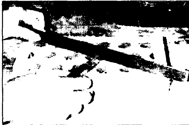
Fig. 1.18. Alabeo del ladrillo.
