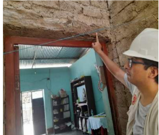
Figura 3.20. Dintel con presencia de polillas.
