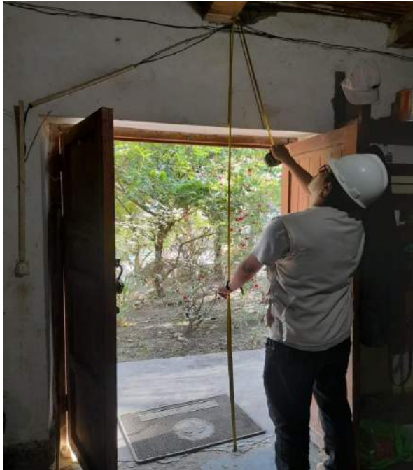
Medición de altura de entrepiso.
