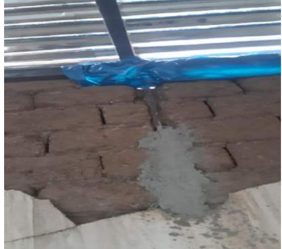
Figura 3.35. Empotramiento de acero 1/2 pulg.
