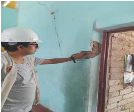
Figura 3.19. Desprendimiento de enlucido de yeso.
