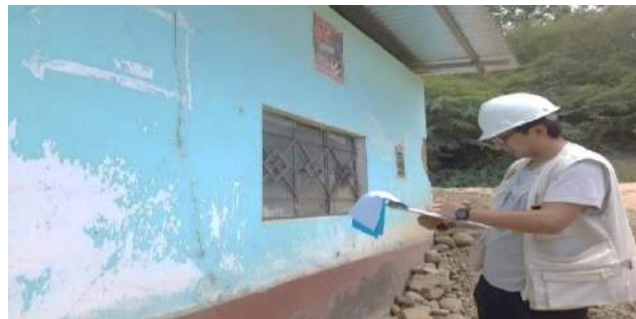
Figura 3.16. Ausencia de balcones o parapetos o algún elemento no estructural.
