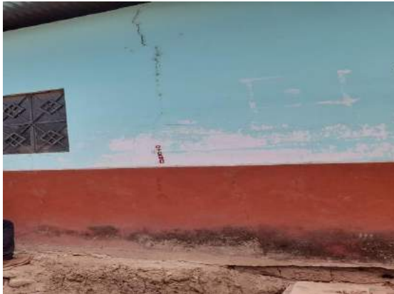
Figura 3.19. Desprendimiento de enlucido de yeso.
