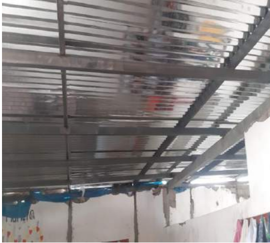
Figura 3.34. Cubierta de material liviano, calamina.
