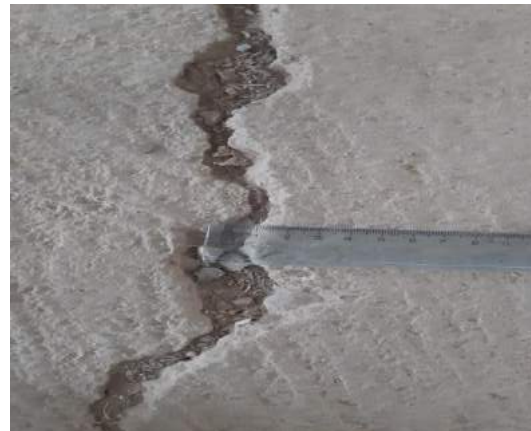
Figura 3.39. Fisura desde ventana a losa. Figura 3.40. Grieta mayor a 3mm en segundo nivel.
