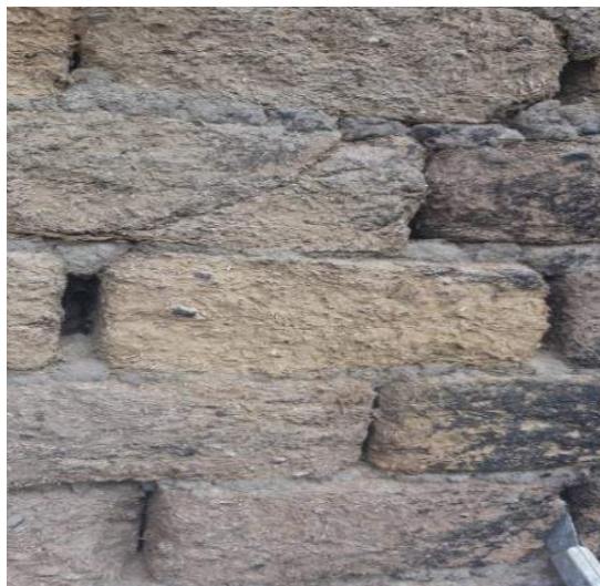
Figura 3.26. Adobe no homogéneo con mortero de barro discontinuo.
