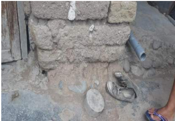
Figura 3.30. Cimiento de piedra con barro. Figura 3.31. Humedad en entrepiso.
