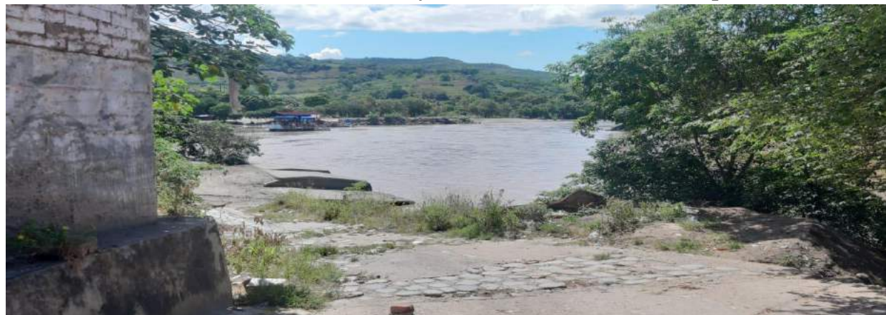
Puerto antiguo cerca a viviendas, la cual no cuenta con algún elemento estructural de refuerzo ante mayores avenidas del rio Chinchipe.
