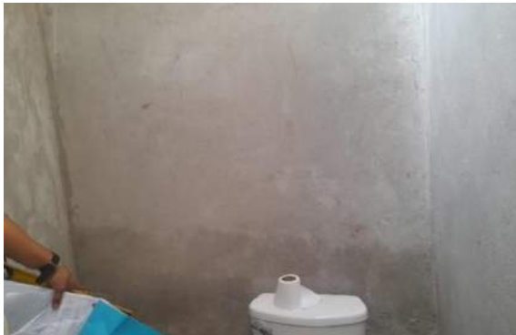
Figura 3.12. Zona húmeda en enlucido con concreto.
