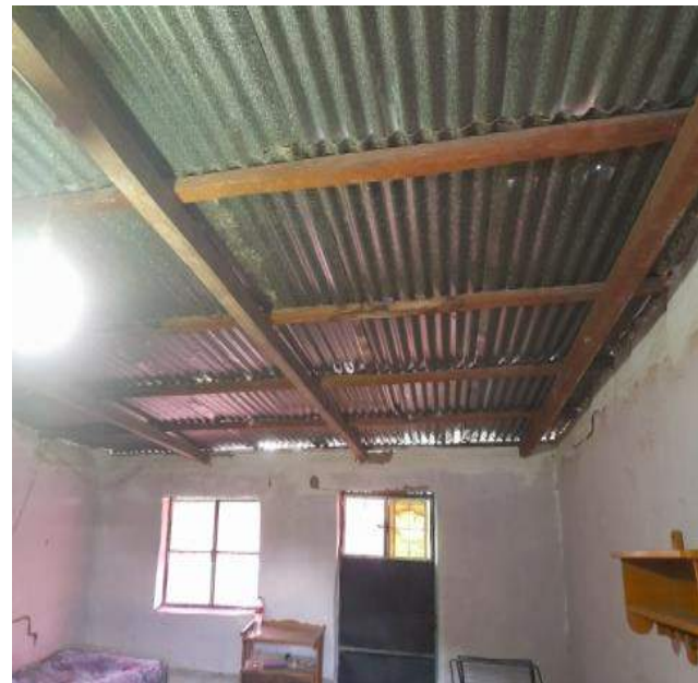
Cubierta de calamina con soportes de madera.
