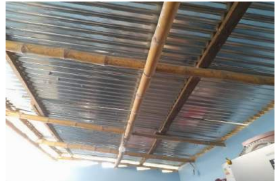
Figura 3.15. Soportes de madera con caña.
