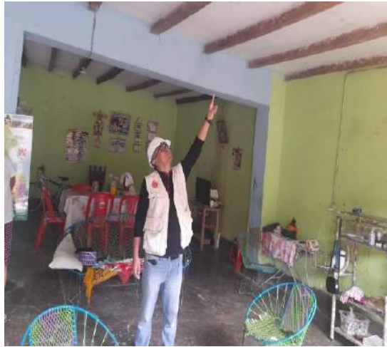
Figura 3.24. Primer nivel sin adecuada distribución de muros.
