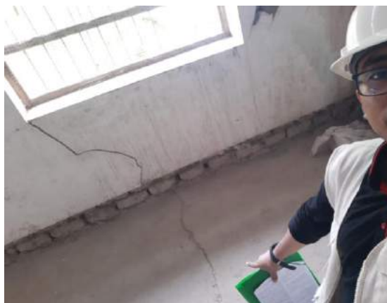
Figura 3.39. Fisura desde ventana a losa. Figura 3.40. Grieta mayor a 3mm en segundo nivel.
