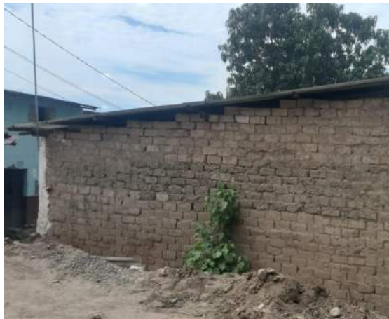
Figura 3.8. Piezas de adobe homogéneos. Figura 3.9. Adecuada traba de piezas de adobe.
