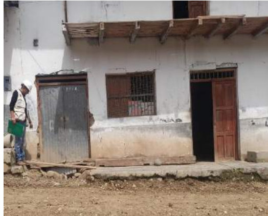
Figura 3.30. Cimiento de piedra con barro. Figura 3.31. Humedad en entrepiso.
