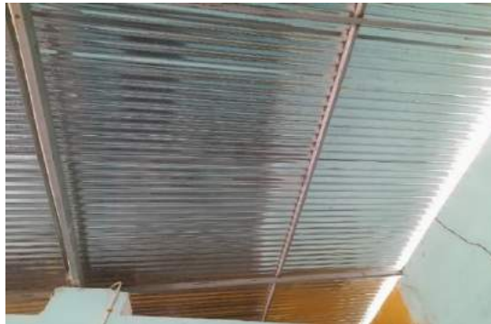
Figura 3.14. Cubierta en buenas condiciones.
