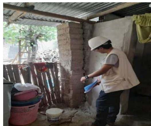
Figura 3.6. Regular distribución de muros. Figura 3.7. Contrafuerte en malas condiciones.
