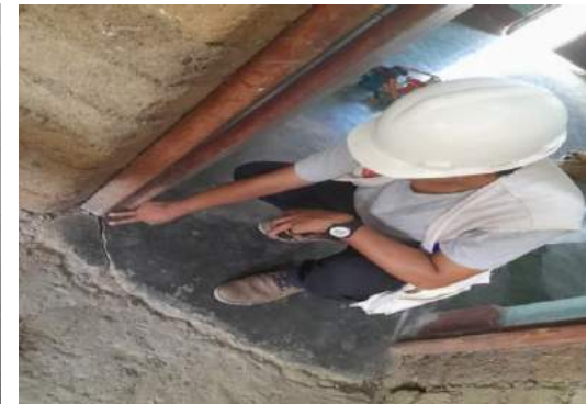
Figura 3.13. Fisuras en piso, descuadre en puerta.
