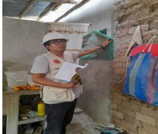
Figura 3.8. Piezas de adobe homogéneos. Figura 3.9. Adecuada traba de piezas de adobe.
