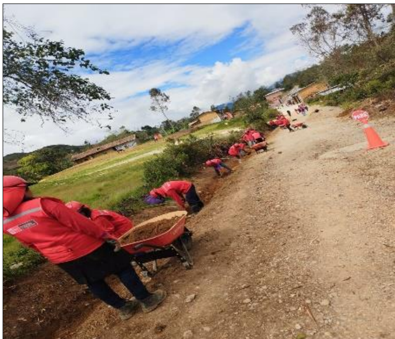
Figura N°04: Excavación manual de zanjas para cunetas terreno normal secc. Prom. 0.50x0.20m en actividad N°02.
