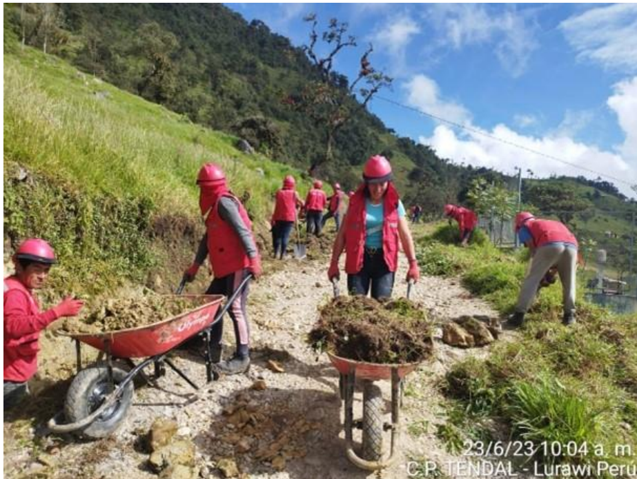
Figura N°08: Acarreo y acopio manual de material excedente en actividad N°02.
