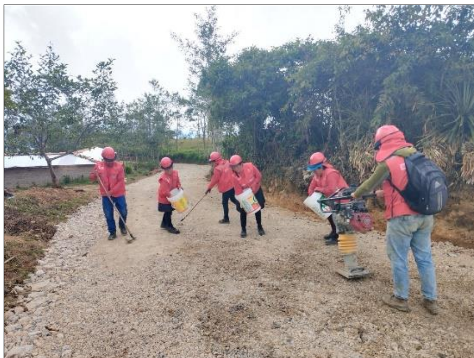
Figura N°06: Relleno con afirmado E=8" compactado en actividad N°01.
