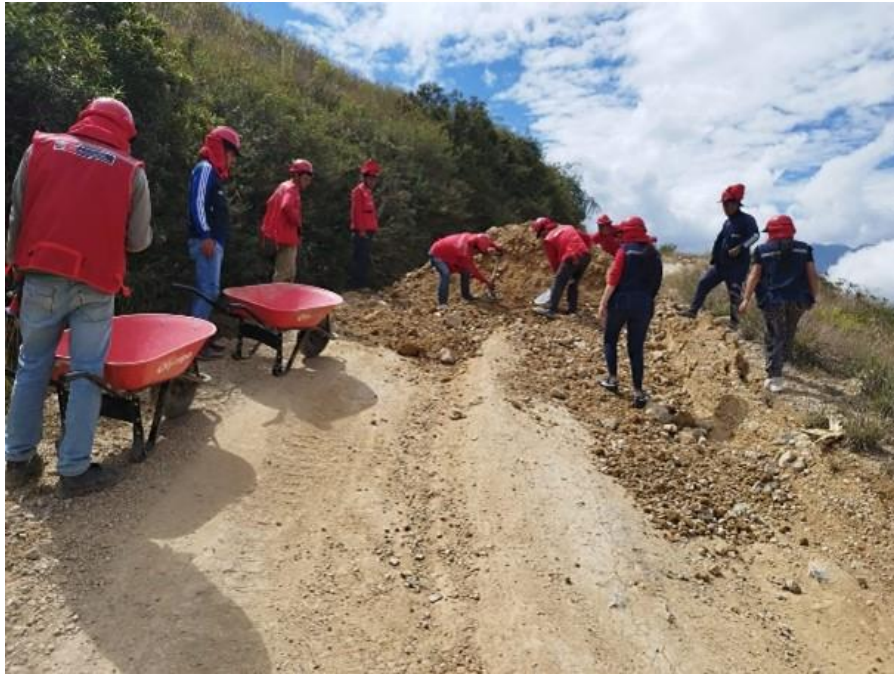
Figura N°07: Extendido de material afirmado en actividad N°02.
