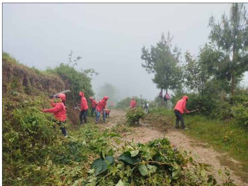
Figura N°02: Limpieza manual de terreno con presencia de maleza y vegetación en actividad N°01.
