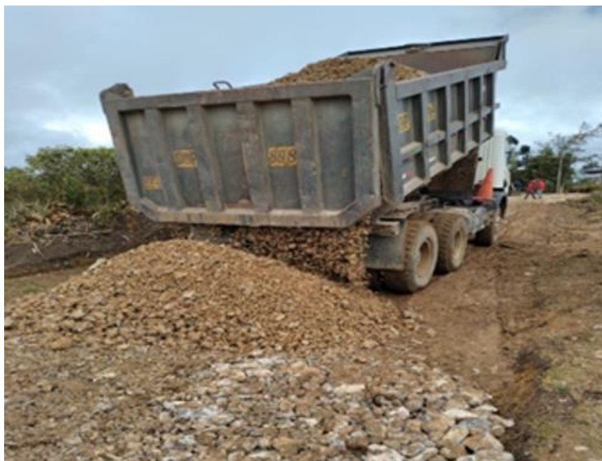
Figura N°06: Relleno con afirmado E=8" compactado en actividad N°01.
