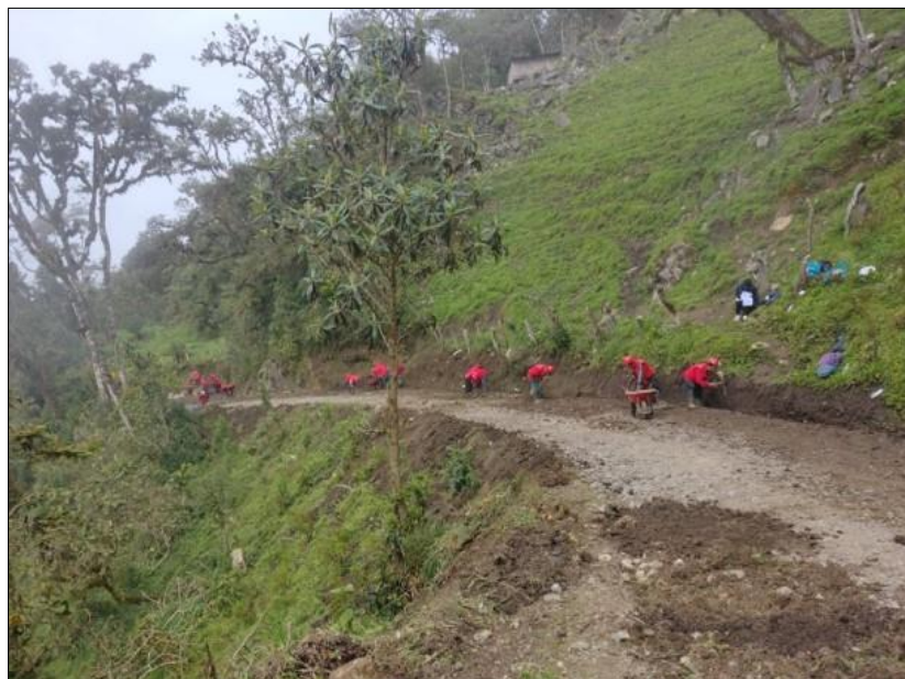
Figura N°04: Excavación manual de zanjas para cunetas terreno normal secc. Prom. 0.50x0.20m en actividad N°02.
