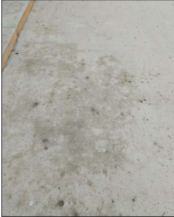
Figura 97: Popouts, observada en la UM-06 de la Sección 02.
