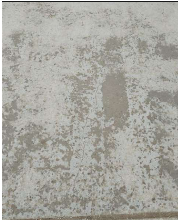
Figura 94: Popouts, observada en la UM-07 de la Sección 01.
