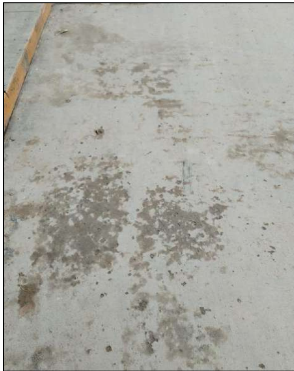
Figura 96: Popouts, observada en la UM-05 de la Sección 02.
