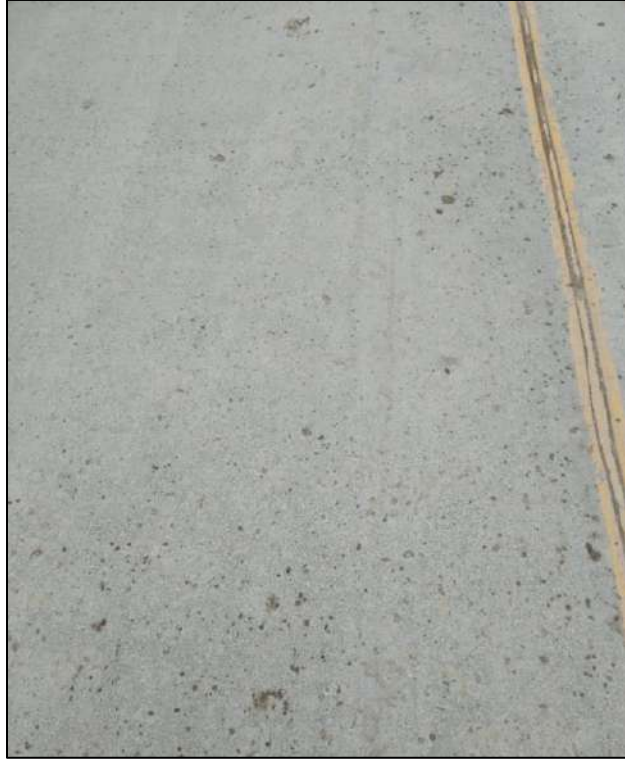
Figura 93: Popouts, observada en la UM-02 de la Sección 01.
