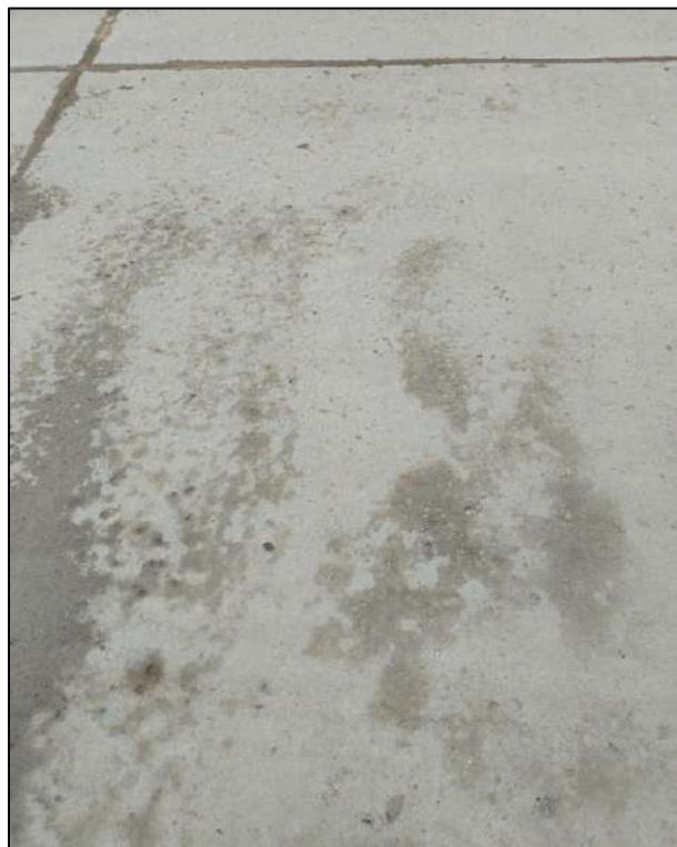
Figura 98: Popouts, observada en la UM-07 de la Sección 02.
