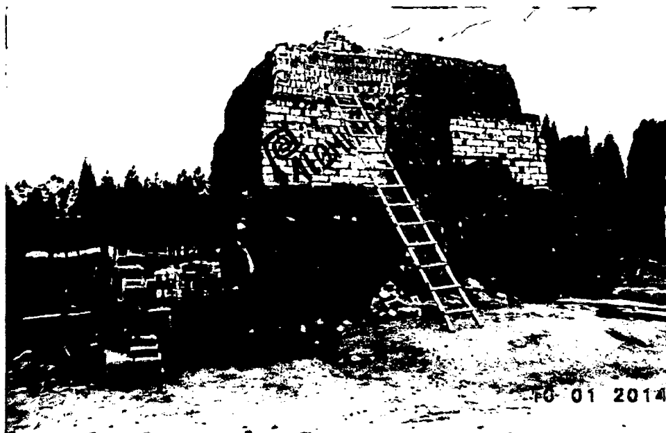
QUEMADO DE LADRILLO
