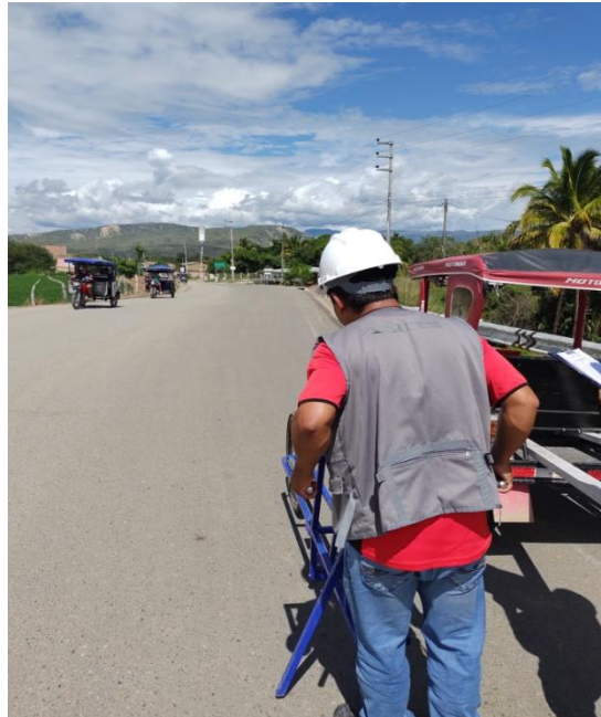
Figura 25: Lectura y Toma de Datos con Merlín Tramo Final Carril Derecho
