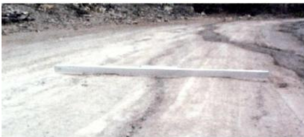
Figura 4.- Gravedad 1: Sensible al usuario, pero profundidad < 5 cm.
