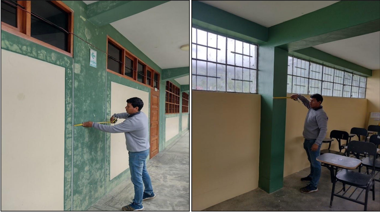
Fotografía 04: Toma de medidas de los elementos constructivos del Bloque I.
