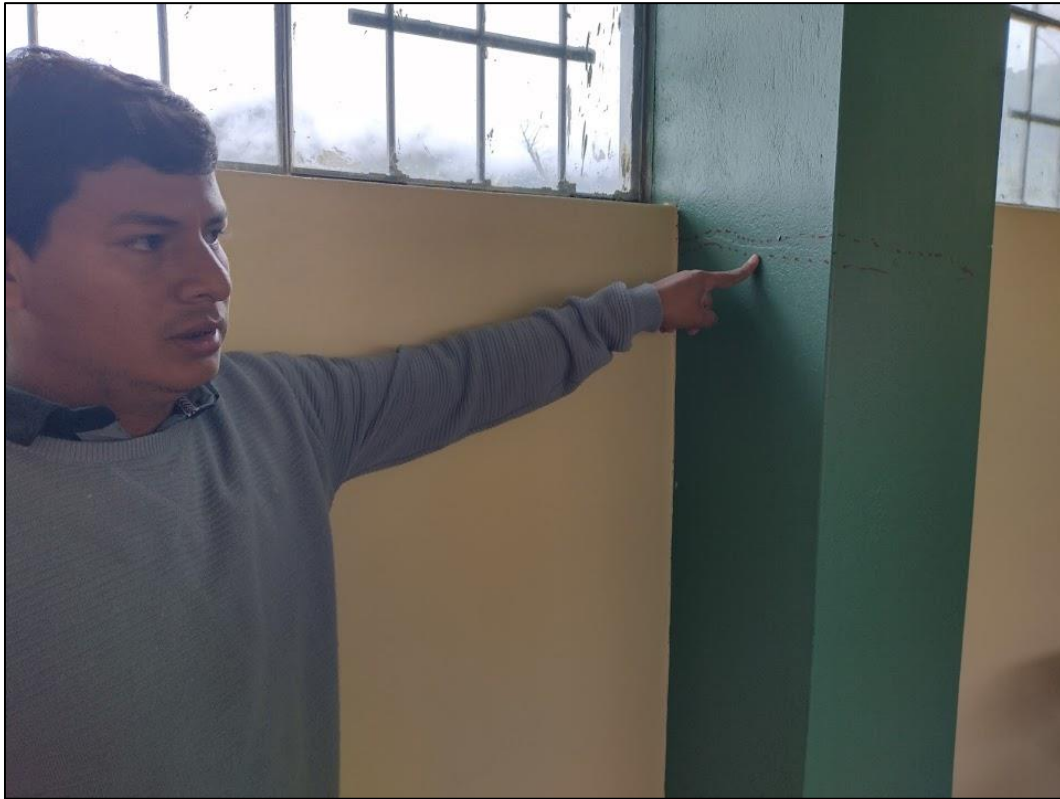
Fotografía 09: Identificación de lesiones en columnas (lesión por fisura).
