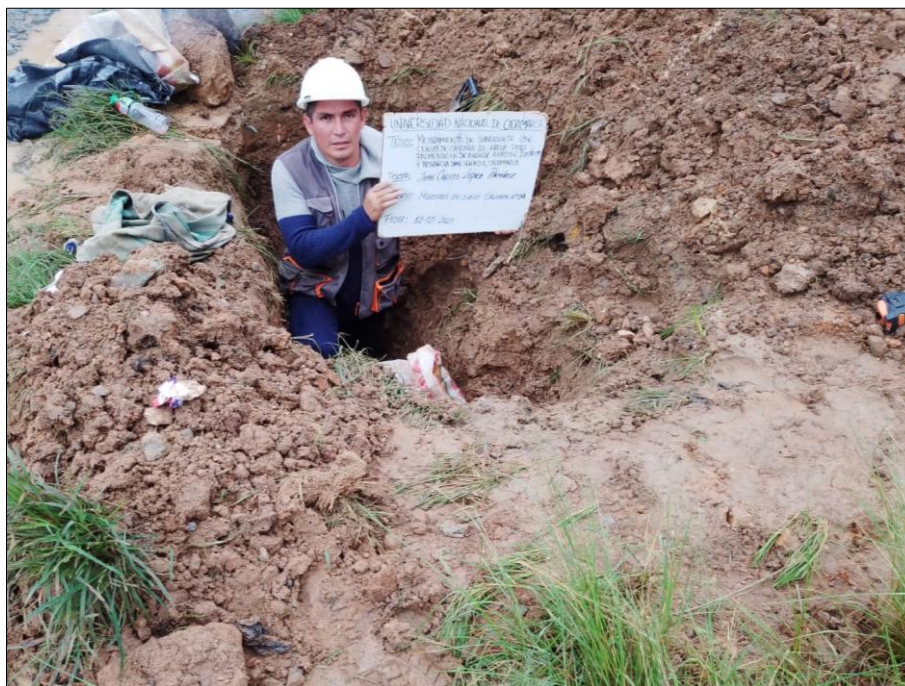
Elaboración de calicatas N° 04
