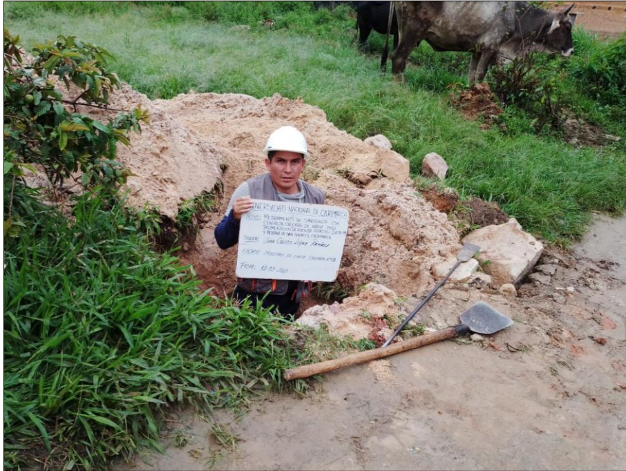
Elaboración de calicata N° 01
