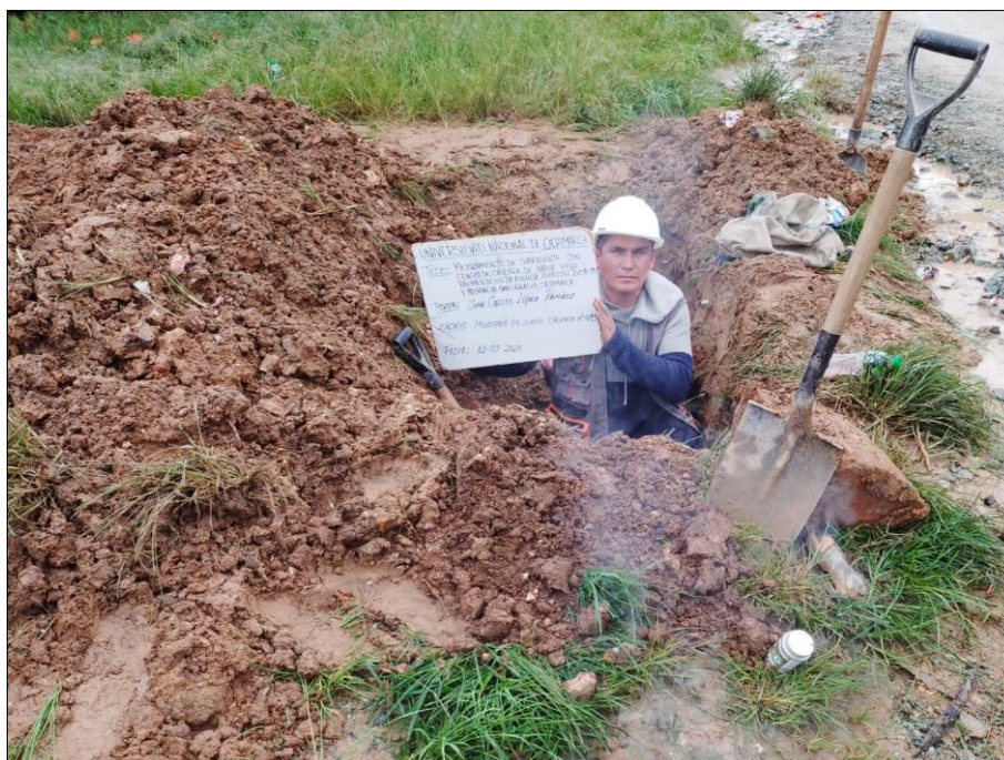
Elaboración de calicatas N° 05
