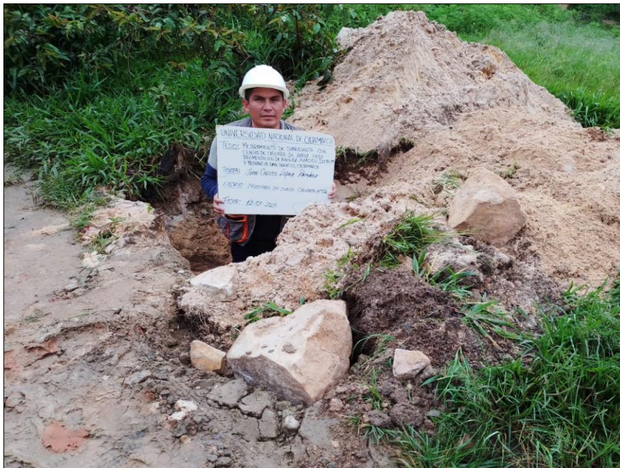
Elaboración de calicata N° 02
