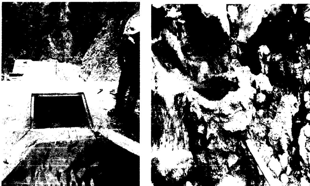
**Foto 1.1.** Izquierda: Vista desde la parte superior de la Captación el Cucharón, captación de quebrada, actualmente con un caudal de 13 – 15 l/s Derecha: se muestra desvíos artesanales del agua por parte de los pobladores para usarlo en regadío.
