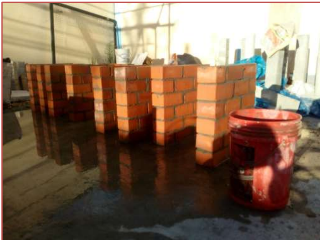
Figura 26. Elaboración de mueres de albañilería
