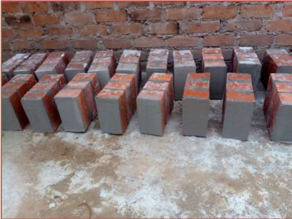
Figura 23. Refrendado de los prismas de albañilería
