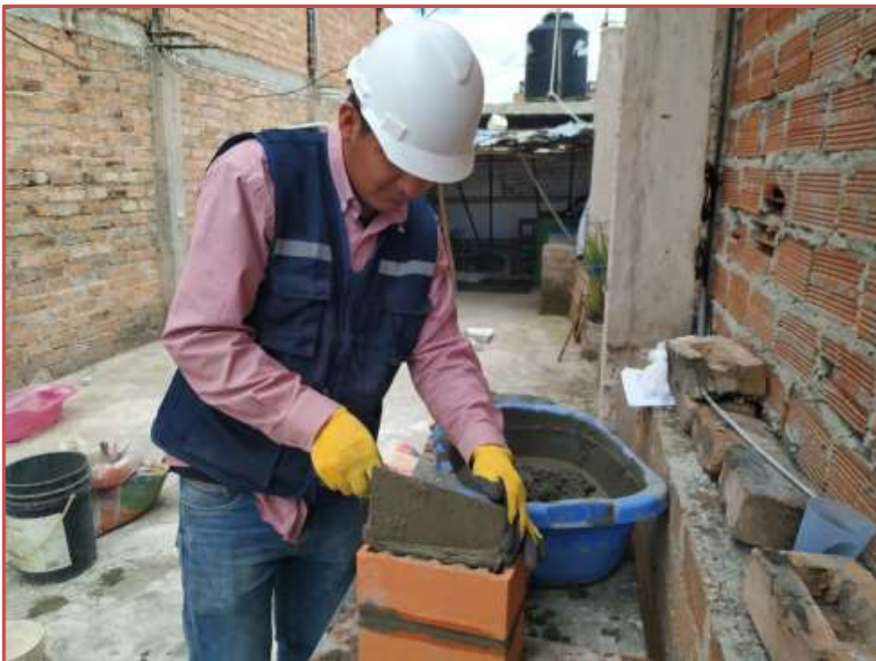
Figura 22. Construcción de los prismas de albañilería
