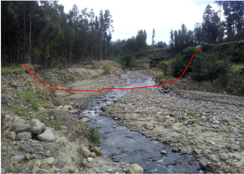
Figura 27. Aguas arriba del Puente San Antonio
