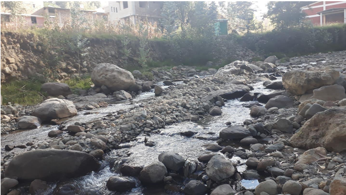
Figura 25. Aguas arriba del Puente Plan Manzanas (apreciación de sedimentos y zonas sedimentables).
