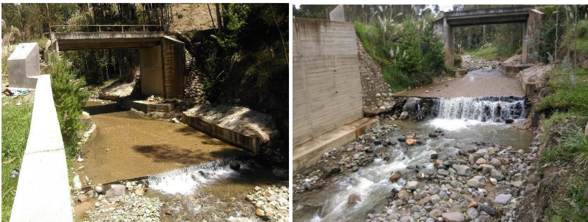
Figura 28. Puente carrozable Plan Manzanas (Izquierda: antes de la máxima profundidad de socavación. Derecha: se aprecia la máxima profundidad de socavación actual).
