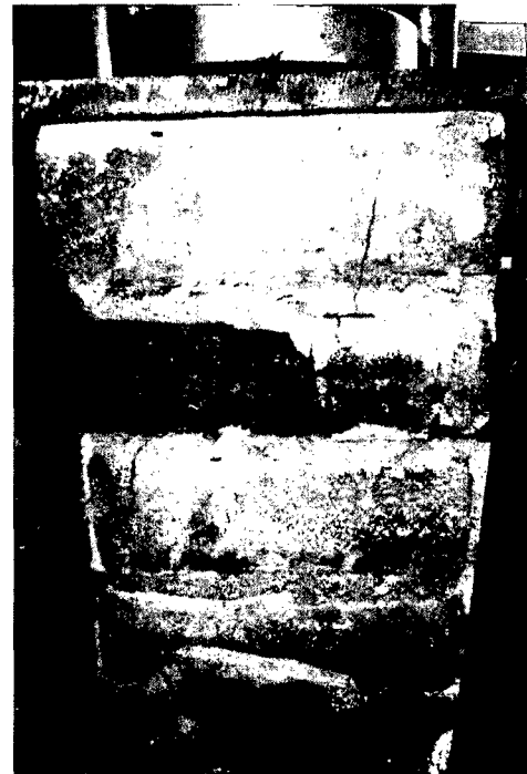
Figura 43. Falla por trituración y fisura vertical vista frontal.
