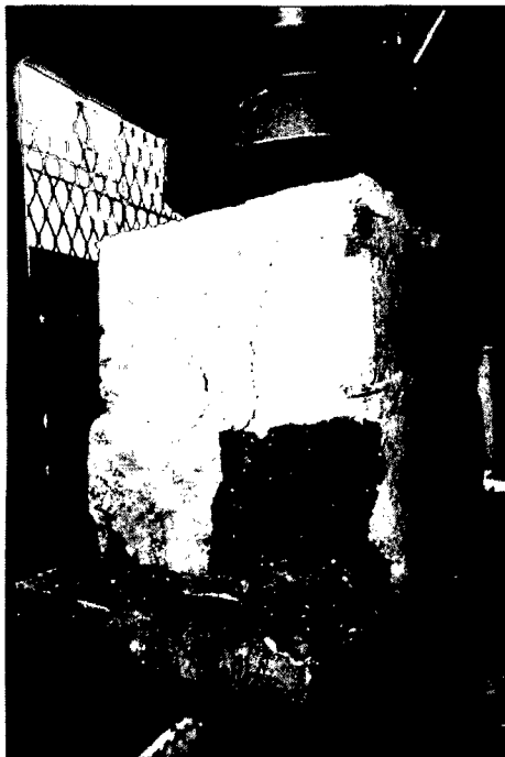
Figura 36. Falla por aplastamiento
